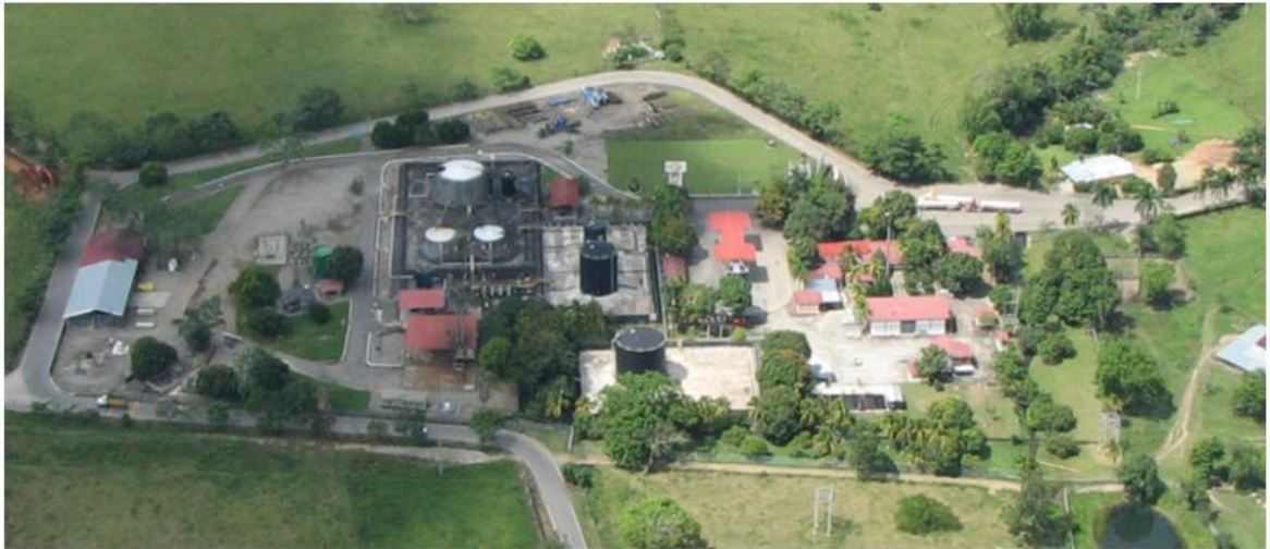
Figura 5. Facilidades de superficie de la Estación Castilla I.
