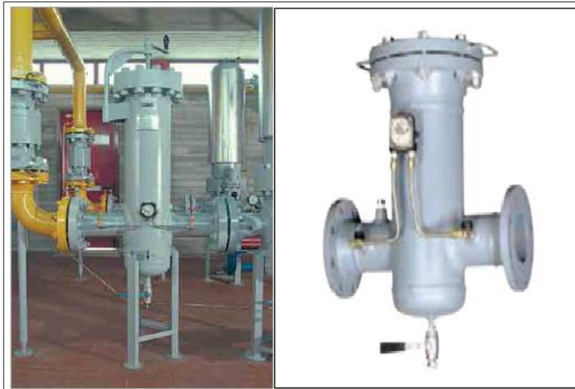
Figura 2. Esquema de un filtro de Cartucho.
