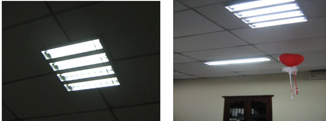
Foto 23. Instalación de lámparas para mejorar condiciones de iluminación
