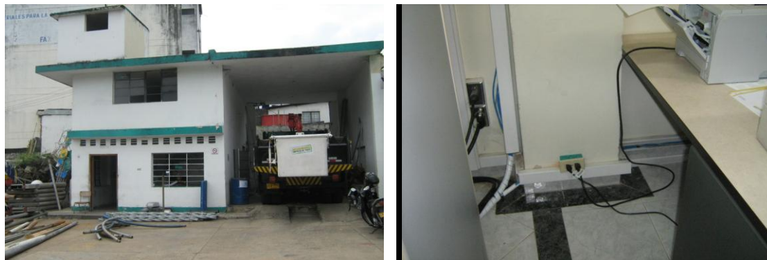
Foto 19. Inspección bodega y oficinas
