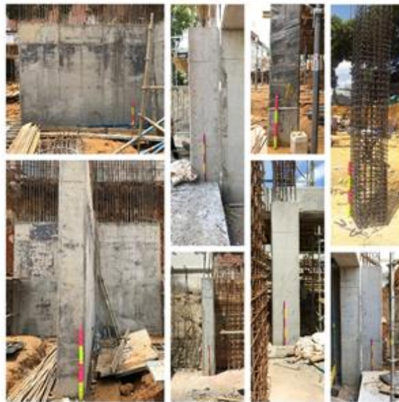
Figura 5. Ubicación del elemento de referencia para la captura de fotografías de elementos estructurales.
