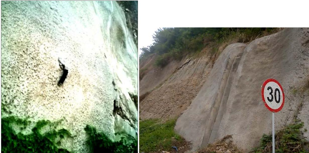
*Figura 38.* Lloradero quebrado (izq), canales sin disipadores de energía (der)
