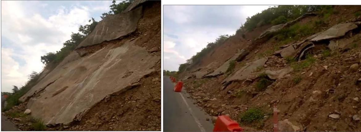
*Figura 36.* Concreto lanzado y pernos de sujeción
