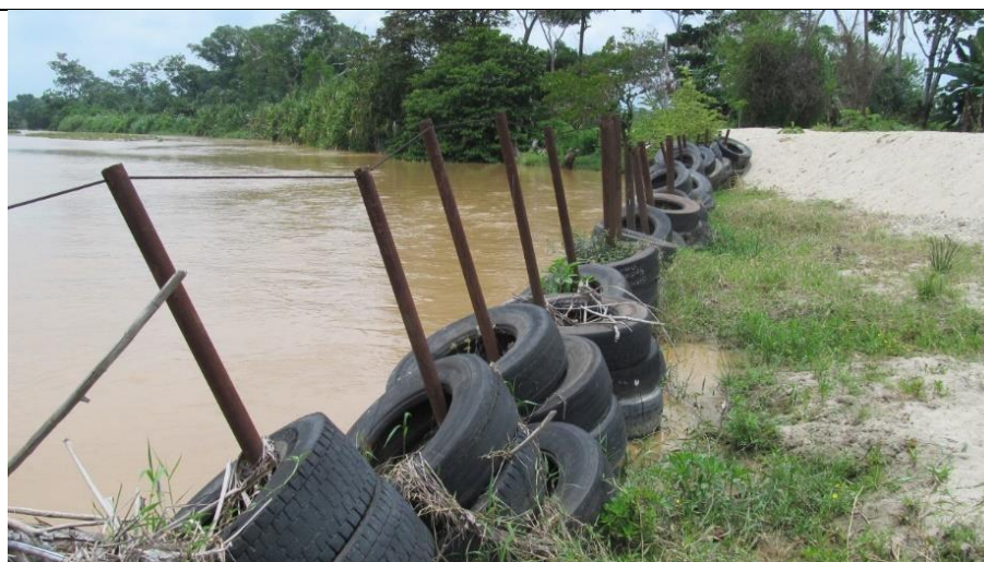
Foto 5 Jarillón y barrera con tubería y llantas instalada por la comunidad de la Vereda La Platanala – Fuente propia 11-11-2016
