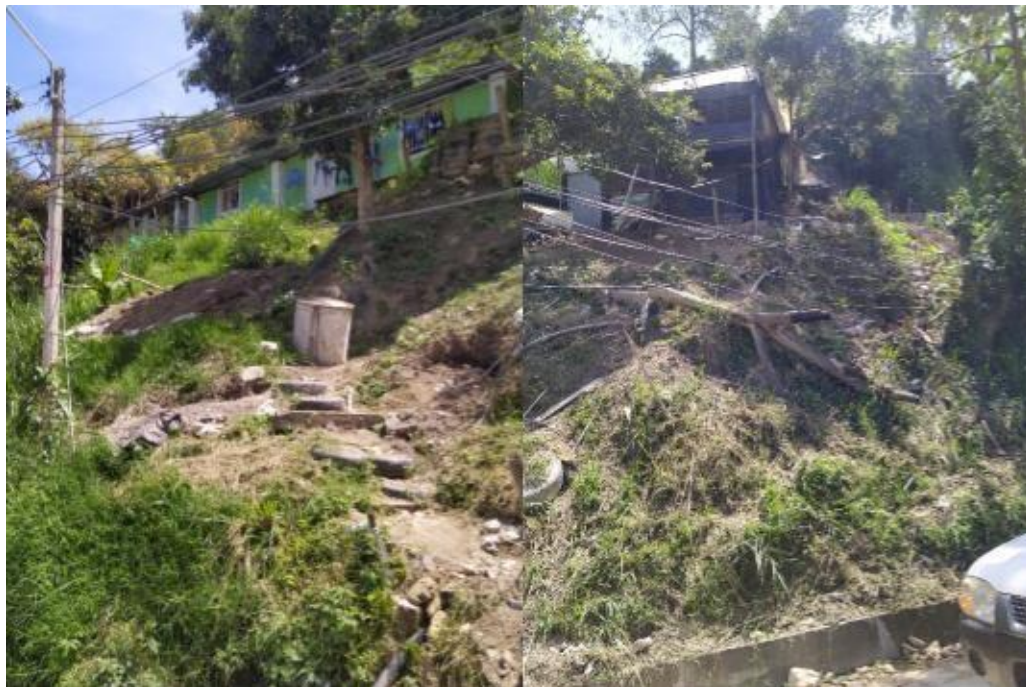
Ilustración 5: intervenciones sobre el talud.
