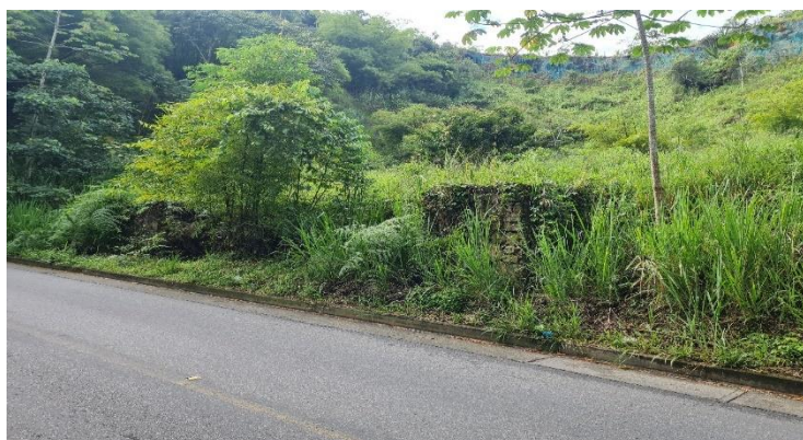
IMAGEN 19: Ruíz E (2022). Obra de mitigación vía UDES 3. Elaboración propia
