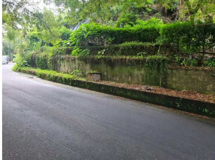
IMAGEN 17: Ruíz E (2022). Obra de mitigación vía UDES. Elaboración propia
