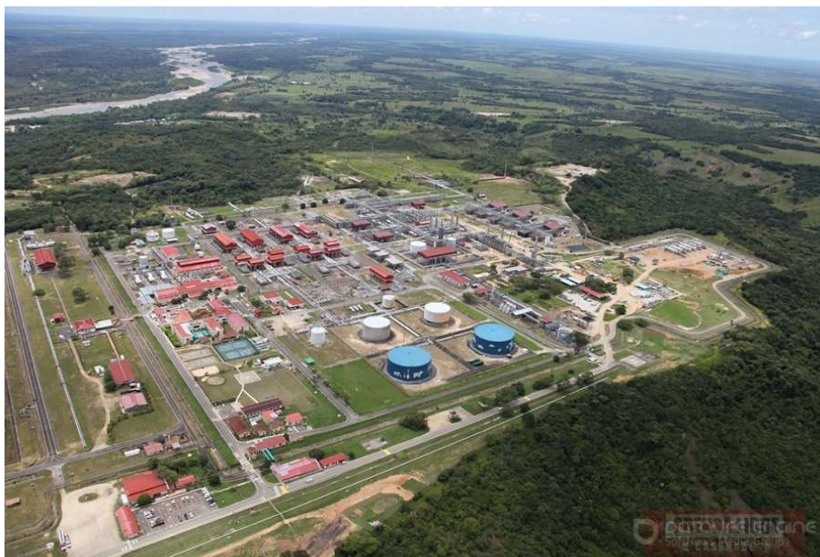
Figura 5. Instalaciones CPF-Cusiana Ecopetrol S.A.
