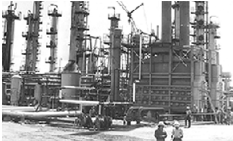
Figura 1. Refinería de Barrancabermeja
