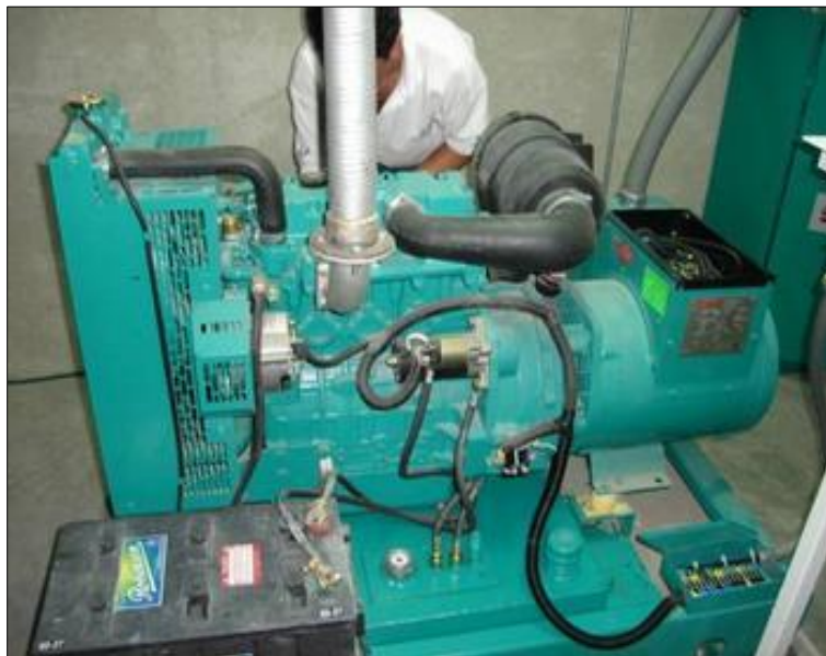
Figura 18. Revisión Motor. Unidades de Generación Diesel.
