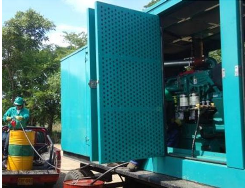
Figura 17. Limpieza General Unidades de Generación Diesel.
