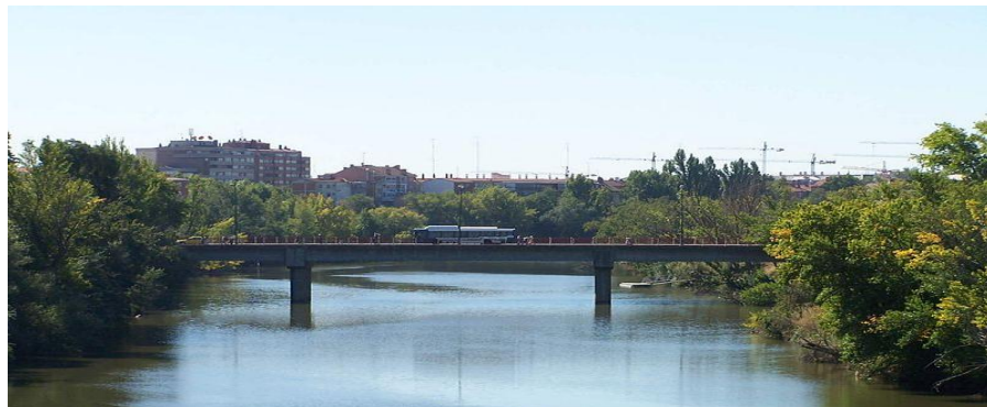
Figura 4. Puente de viga sobre el río Pisuerga (España)
