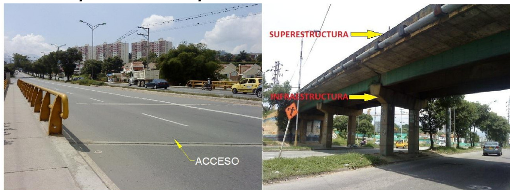
Figura 2. Componentes de un puente
