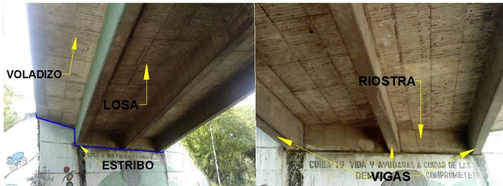
Figura 3. Partes del puente
