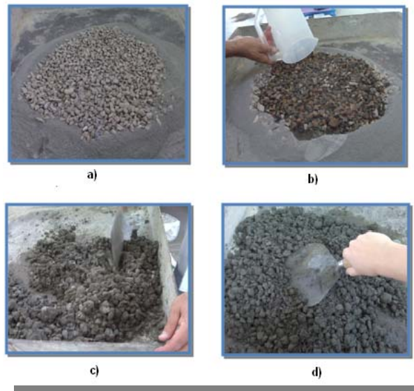
Fotografía 5. Preparación de la Mezcla
