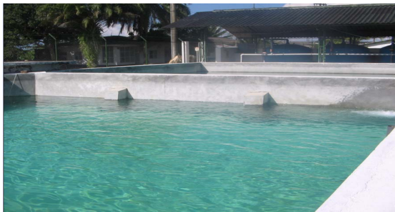
Planta de tratamiento de Puerto Leguizamo Fuente: Empresa de Acueducto de Puerto Leguizamo. 2006. Tomada por los autores
