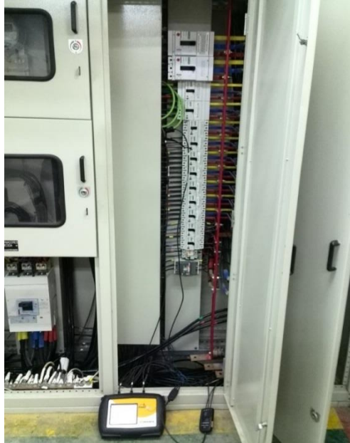
Figura 32. Instalación del equipo edificio Mamitza Bayer
