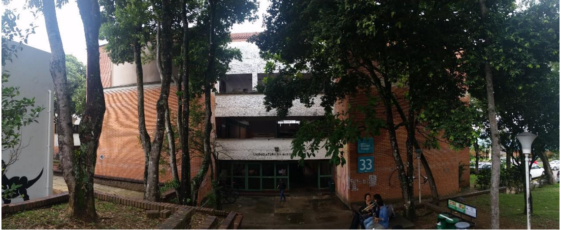
Figura 45. Fachada del edificio Daniel Casas
