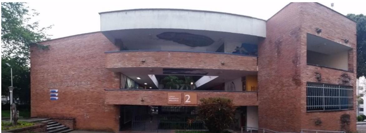
Figura 1. Fachada del edificio Federico Mamitza Bayer
