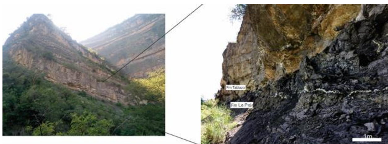
FIGURA 20: Afloramiento del talud expuesto. Se observa el contacto entre las lodolitas grises (Fm La Paja) y las areniscas amarillas competentes (Fm Tablazo)
