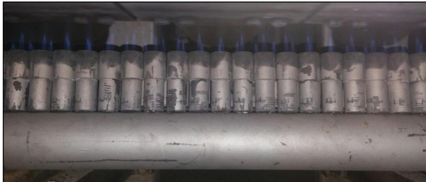
Figura 57. Alineación y limpieza de las toberas.
