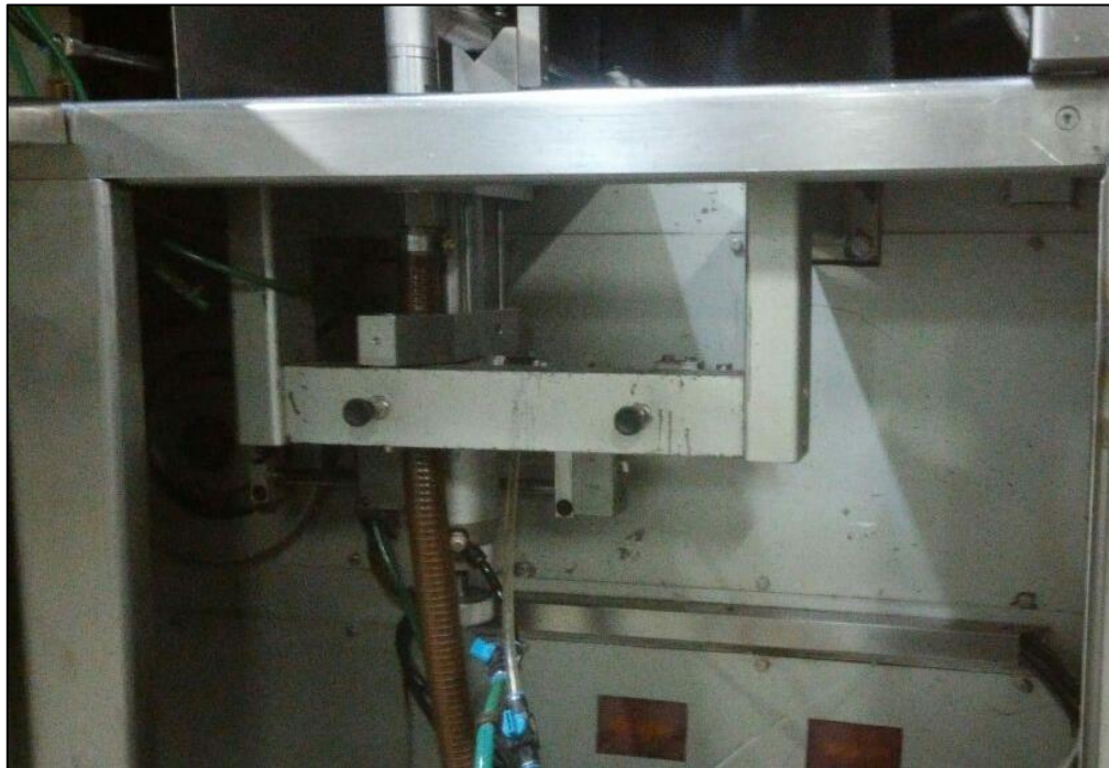
Figura 47. Lugar de difícil acceso a la bomba.
