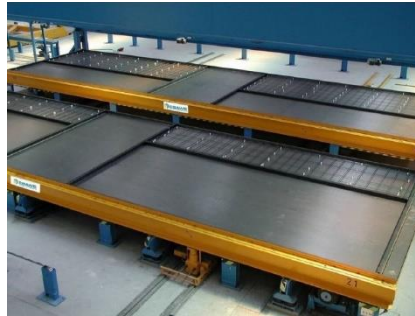
Figura 8: Estación de armado de refuerzos y piezas embebidas
