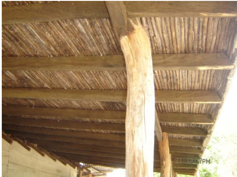
Figura 42. Base de la cubierta (varas de lata) en vista inferior
