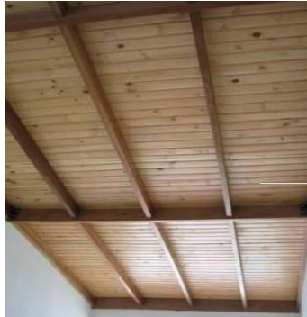
Figura 68. Proyección de la cubierta con machimbre
