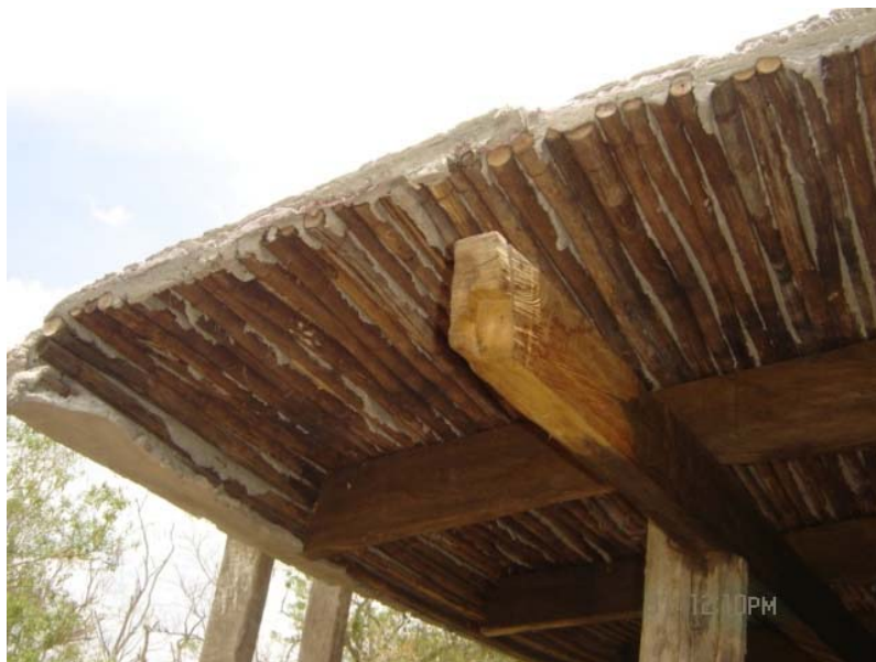
Figura 43. Vista lateral de la cubierta
