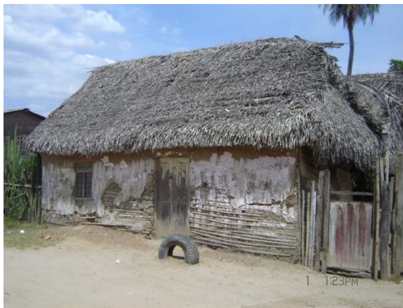
Figura 38. Vivienda antigua – detalles del muro en bahareque y varas de lata
