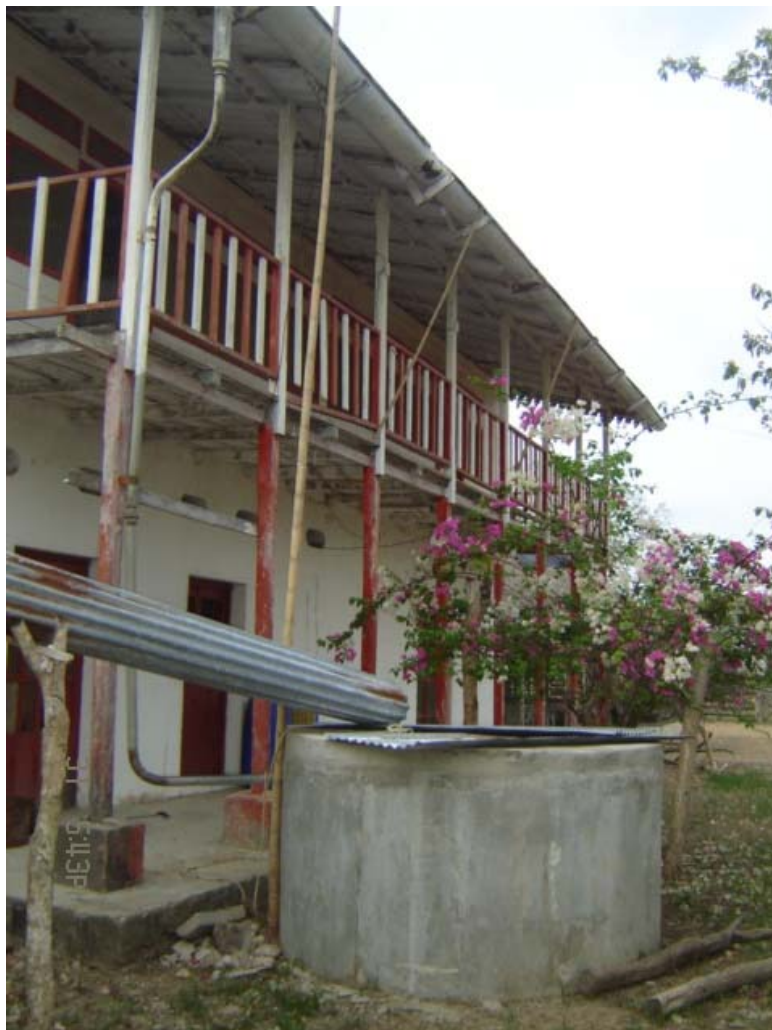
Figura 54. Tanque para almacenamiento de agua
