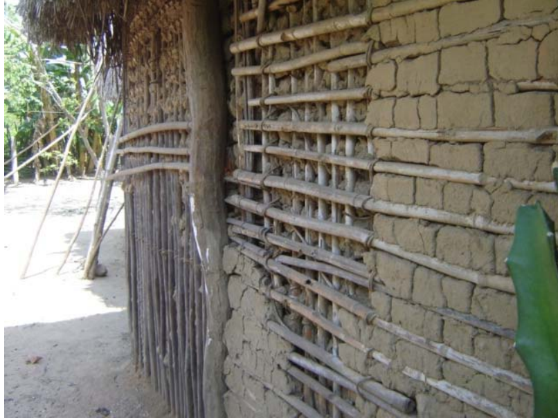
Figura 39. Armazón de un muro con varas de lata
