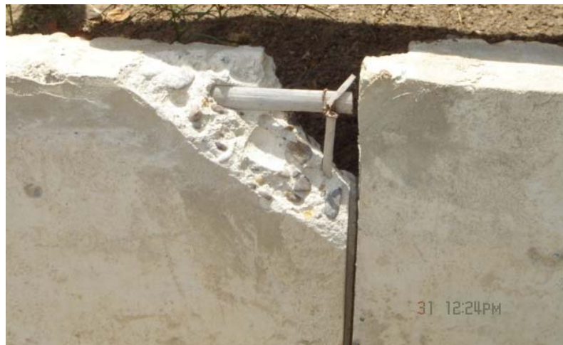
Figura 51. Detalle de la malla de refuerzo en la loseta
