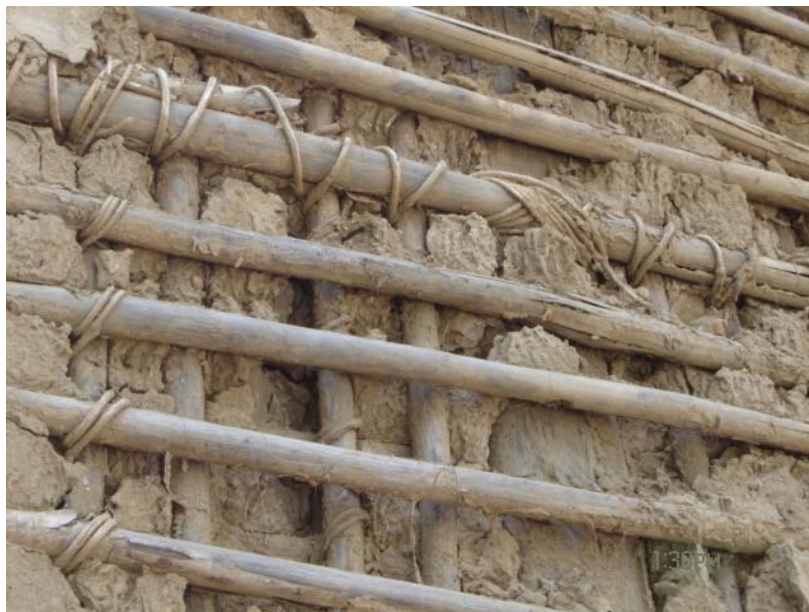
Figura 41. Amarre con bejuco del armazón de un muro
