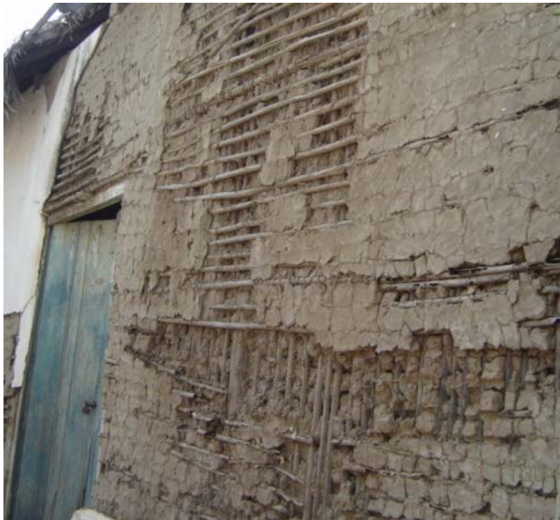
Figura 40. Vivienda antigua con muro en bahareque y varas de lata
