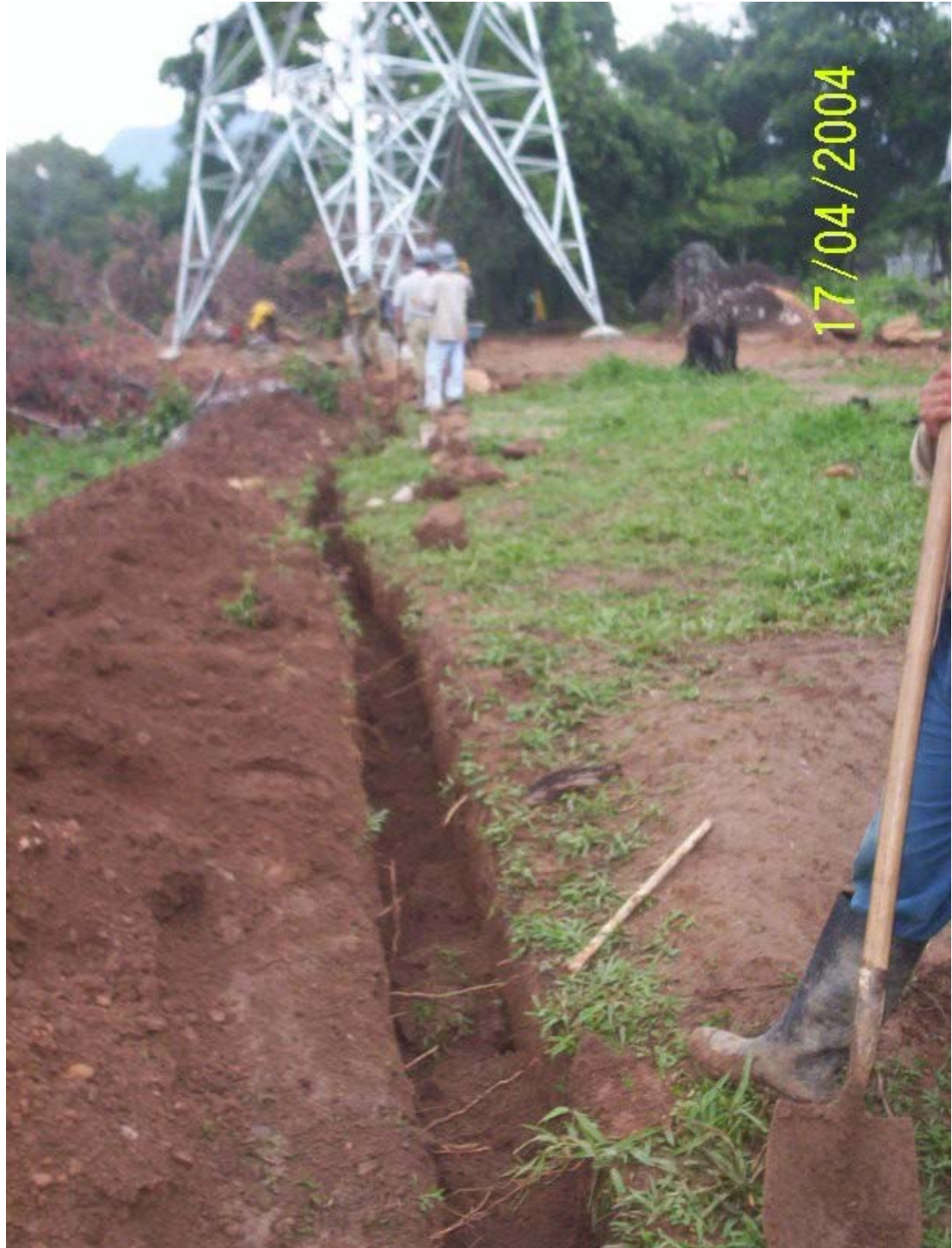
Figura 38. Fotografía de excavación de la zanja para la instalación de los contrapesos. Vista frontal.
