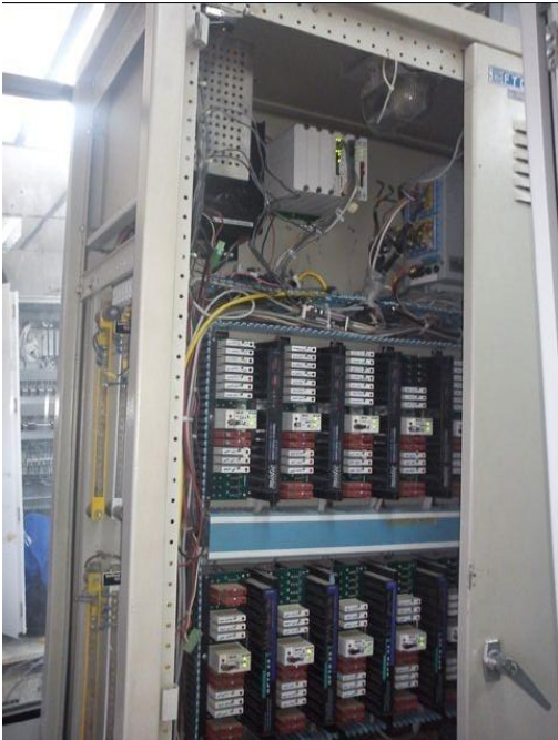
Fuente: Registro Fotográfico Terminal Puente Aranda
