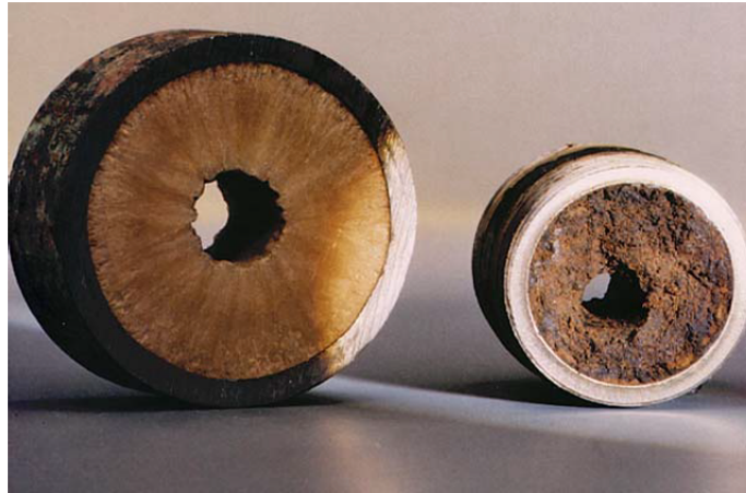
Fig. 1. Tubería bloqueada por scales .
