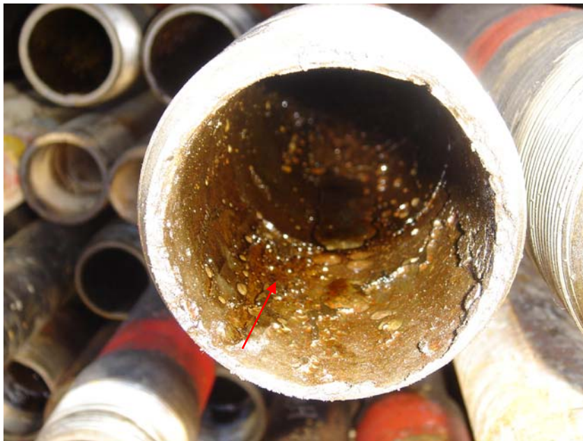
Figura 4-8: Muestra de corrosión en pin.
