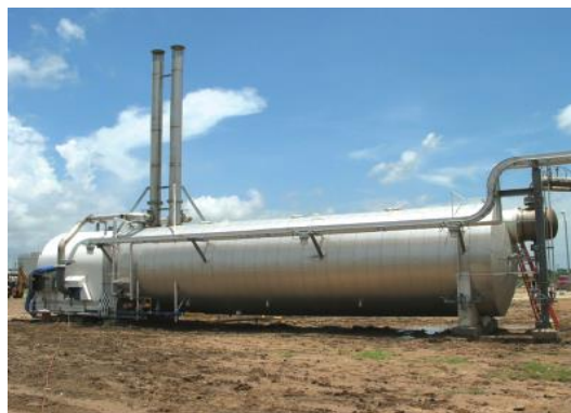
Figura 18. Vaporizadores de Baño de Agua de Calentamiento Indirecto (IFWB)
