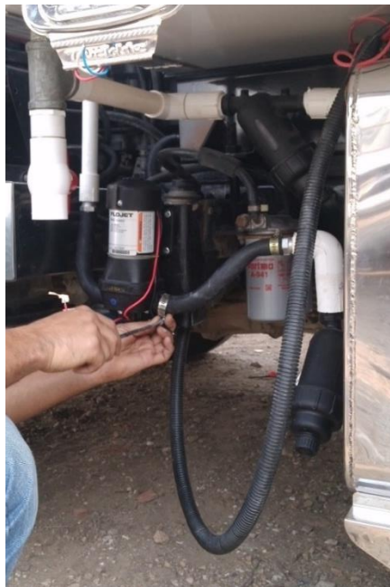
Figura 378. Instalación de la bomba
