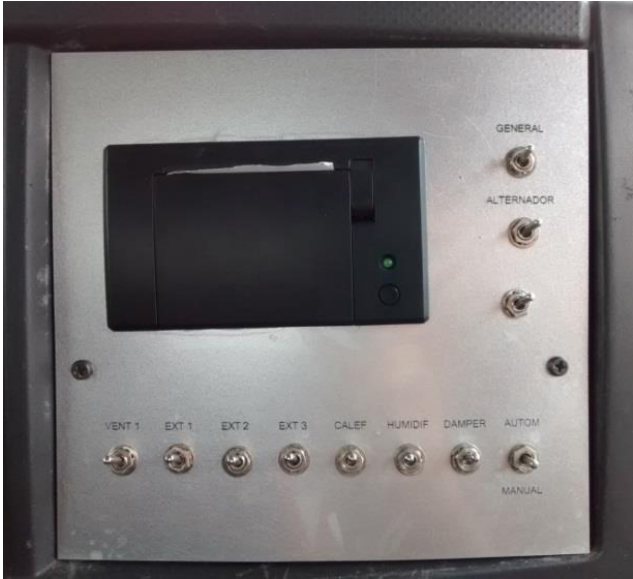
Figura 391. Tablero principal de distribución
