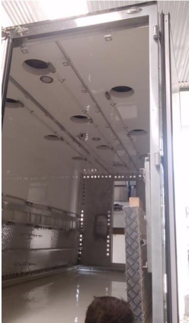
Figura 380. Inspección visual de los elementos del furgón
