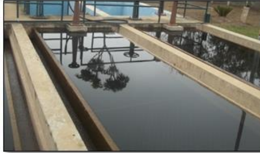
Figura 13. Tanques sedimentadores
