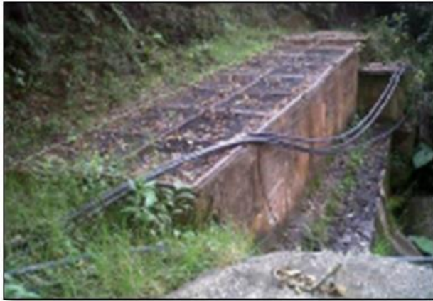
Figura 2. Desarenador Quebrada el Ramo
