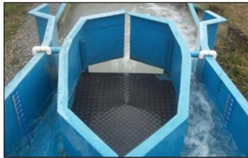
Figura 5. Canaletas Parshall presedimentador
