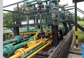
En el manifold de inyección de gas lift se ha presentado poros y recientemente se cambió una Tee de la tubería de 4". Dijo el operador que cuando la cambiaron, miraron por dentro y la vieron muy corroída, que parecía un mapa. Inyección de gas lift a 1500 psi por tubería de 2" hacia el pozo LGN 1 y LGN 3.
