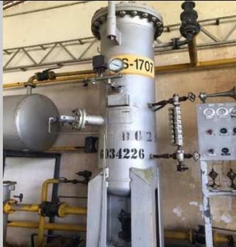
Scrubber de instrumentación y equipos, y gas veredal también. Este gas veredal sale por una tubería de 2" que presenta espesores entre 0,195-0,200 pulgadas. Equipos trabajan a 15 psi.
