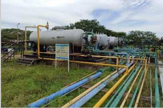
El proceso comienza en los separadores, donde llega crudo con gas y agua, desde los pozos LGN 1, LGN 3 y LGN 6 de los cuales el pozo 1 y 3 funcionan con gas lift. Antes se utilizaba gas lift para el pozo 6 y 4 pero ahora el 4 está abandonado y el 6 es electrosumergible. Cuando los separadores pasan de 90 psi, votan gas hacia la tea. Aproximadamente se queman entre 6-7 miles pies<sup>3</sup> diarios en la tea.
