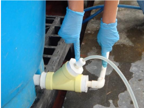
Figura 93. Entrada de solución y agua
