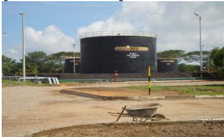
Figura 4. Fotografía de un Eliminador de Agua Libre.
