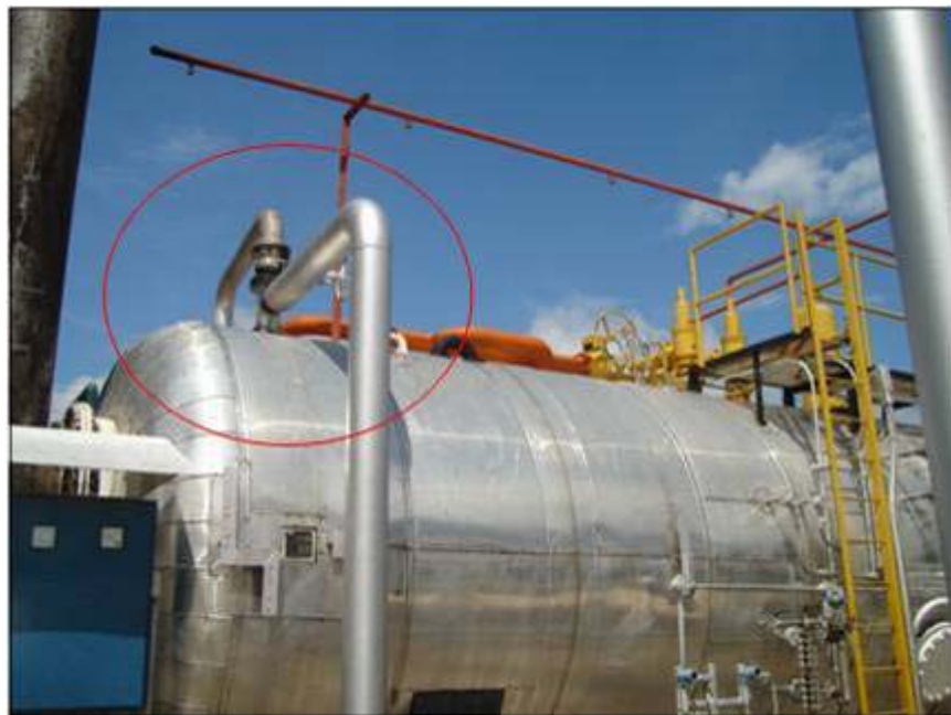
Figura 15. Fotografía de la entrada de crudo a la Sección de Calentamiento.
