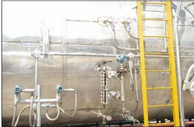
Figura 16. Fotografía del control de nivel y temperatura de la Sección de Calentamiento.
