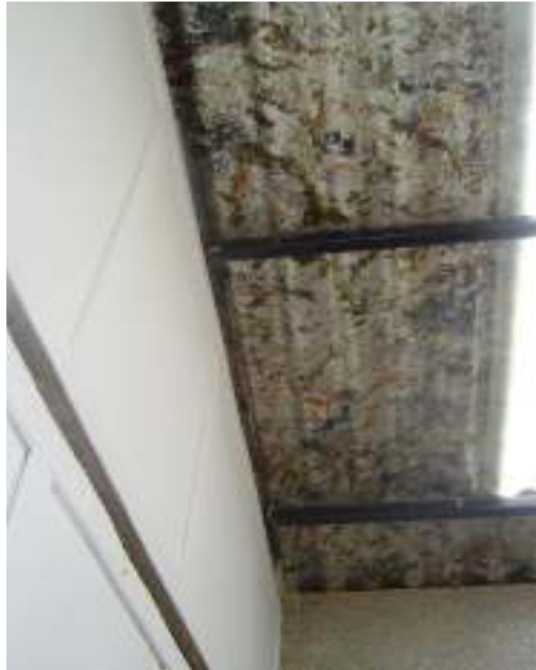
Figura 6. Teja termo acústica Ecoplak aplicación típica
