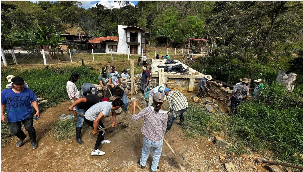
Figura 14. Supervisión de la Construcción del Puente "Las Ánimas".
