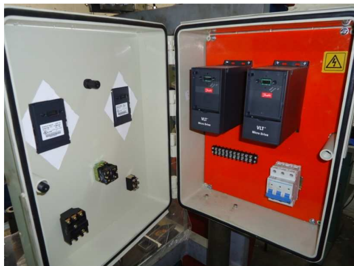
Figura 157. Vista del montaje de los elementos
