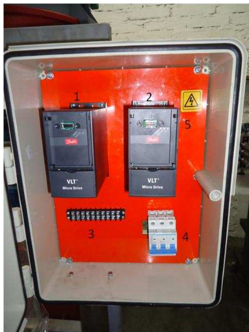
Figura 158. Vista interna de los la caja. Componentes
