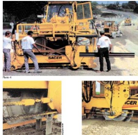
Figura 3.7. Equipo para prefisuración junta activa
