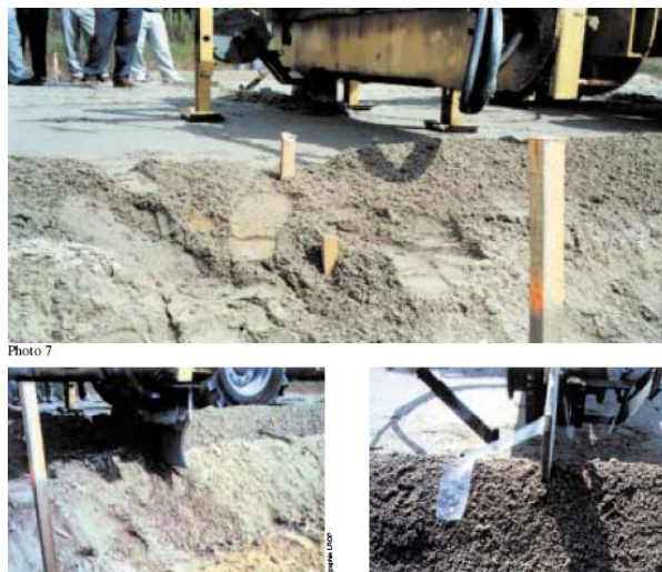
Figura 3.8. Equipo para prefisuración OLIVIA
