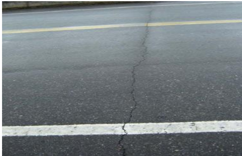
Figura 1.3. Representación de una fisura transversal
