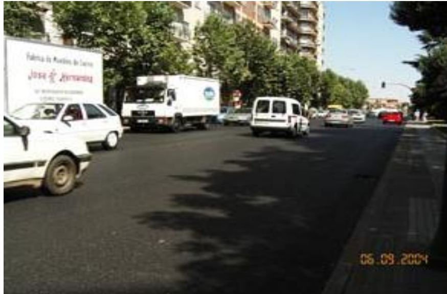
Figura 3.29. Vía urbana en Salamanca después del procedimiento de reparación
