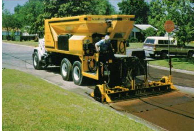
Figura 3.10. Procedimiento de aplicación de lechada asfáltica
