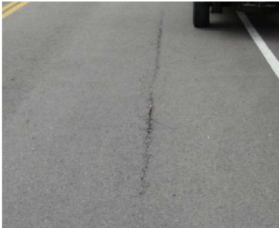
Figura 1.4. Fisura longitudinal y transversal generada por efecto de las juntas de construcción, respectivamente
