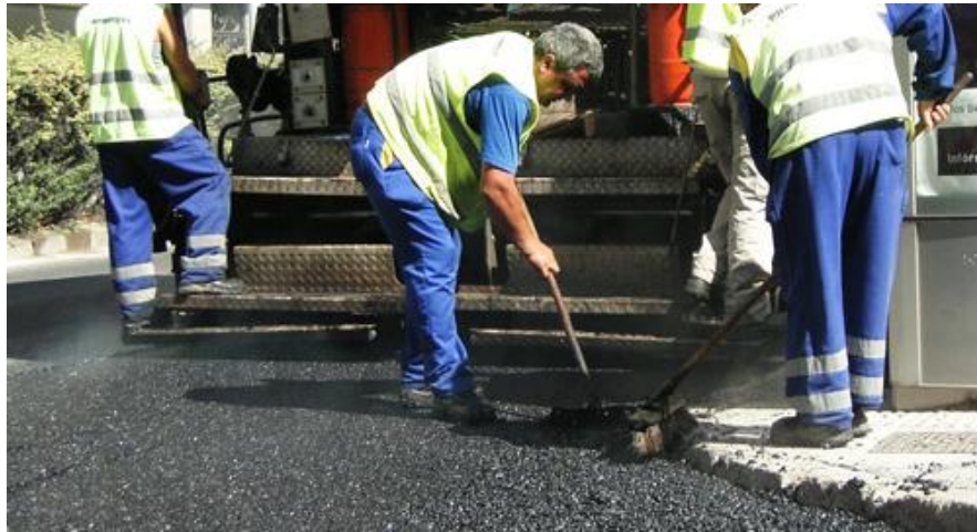
Figura 3.28. Proceso de rehabilitación de una vía urbana en Salamanca con mezcla asfáltica modificada con betún
