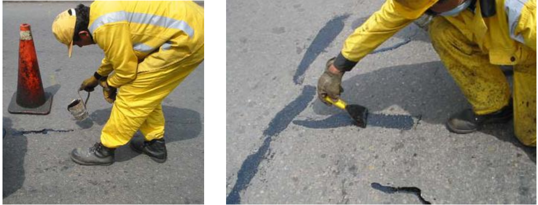
Figura 3.2. Procedimiento de sellado de fisuras
