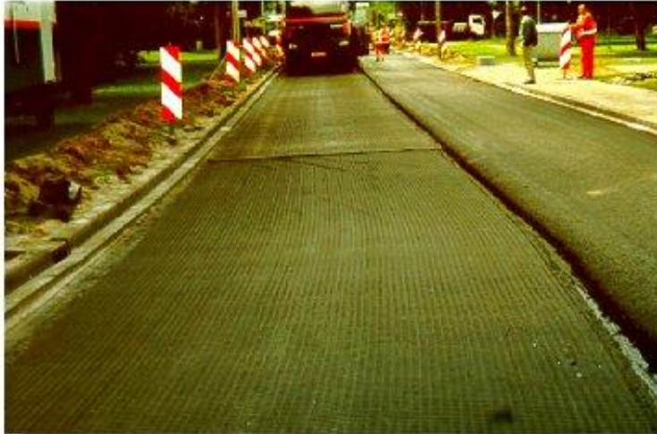
Figura 3.19. Geomalla de refuerzo
