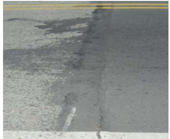
Figura 1.4. Fisura longitudinal y transversal generada por efecto de las juntas de construcción, respectivamente
