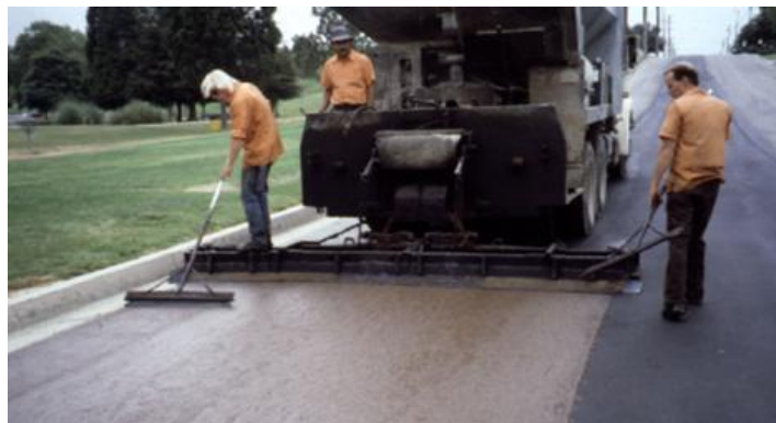
Figura 3.9. Ejemplo de utilización de lechada asfáltica
