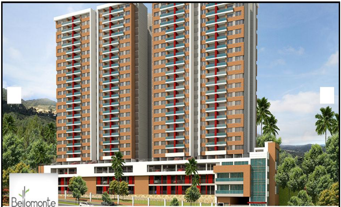
Figura 2. Conjunto residencial Bellomonte
