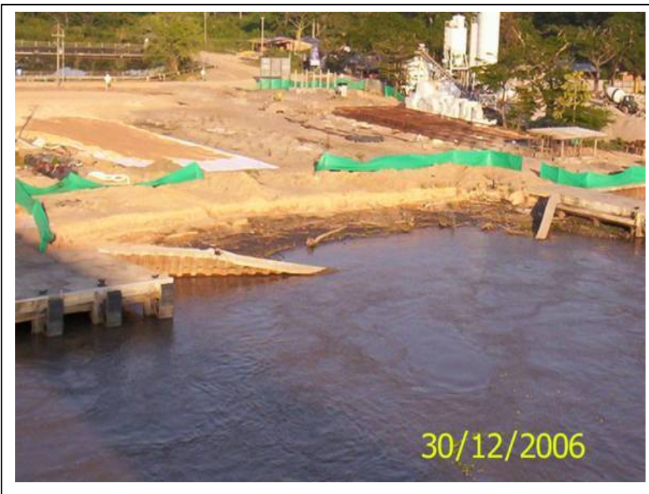
Figura 52. Socavación del tablestacado del Nuevo Puerto Modular. Diciembre de 2006
