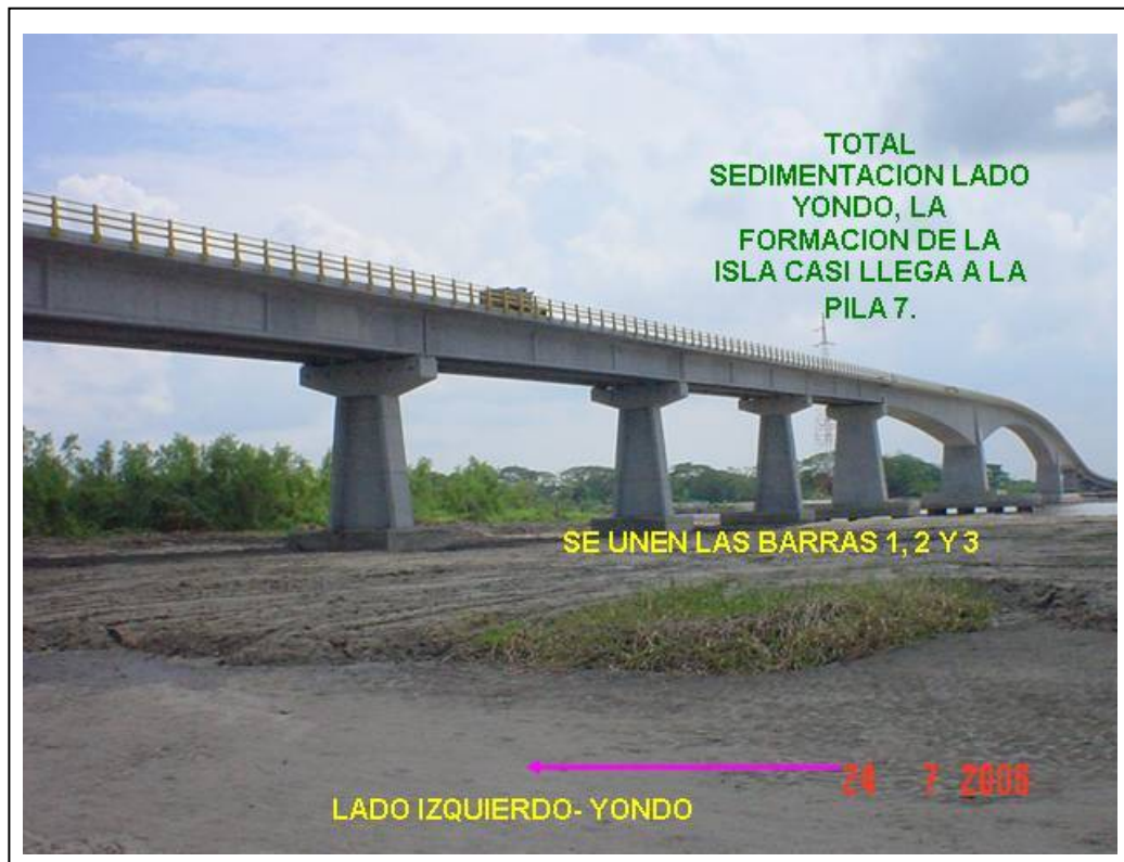
Figura 37. Avance de la Sedimentación durante la construcción del puente.
