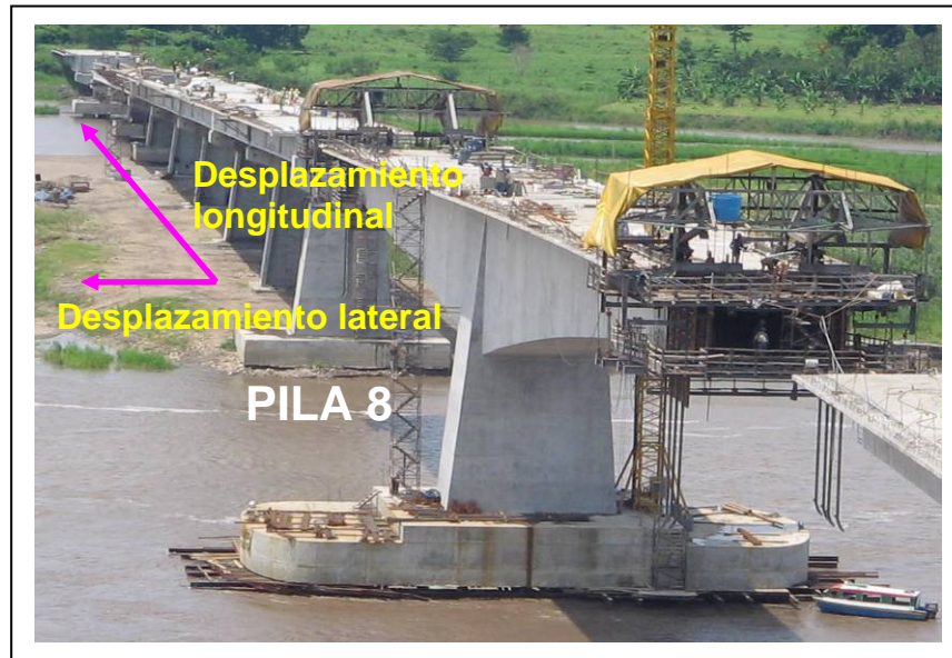
Figura 43. Avance de la Sedimentación durante la construcción del Puente.
