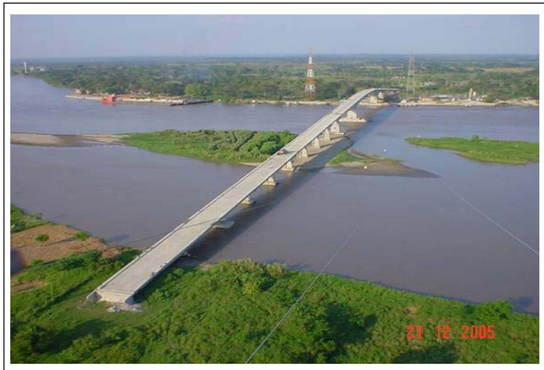
Figura 1. Puente Guillermo Gaviria Correa
