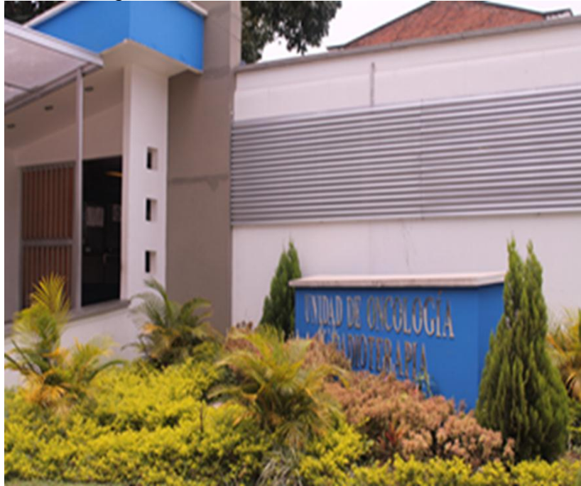
Imagen 1. Fachada de la Unidad de Oncología y Radioterapia del Hospital Ramón González Valencia. 1 Agosto 2013
