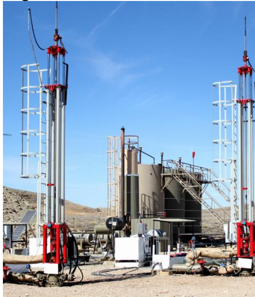
Figura 6. Unidad de Bombeo Morlift
