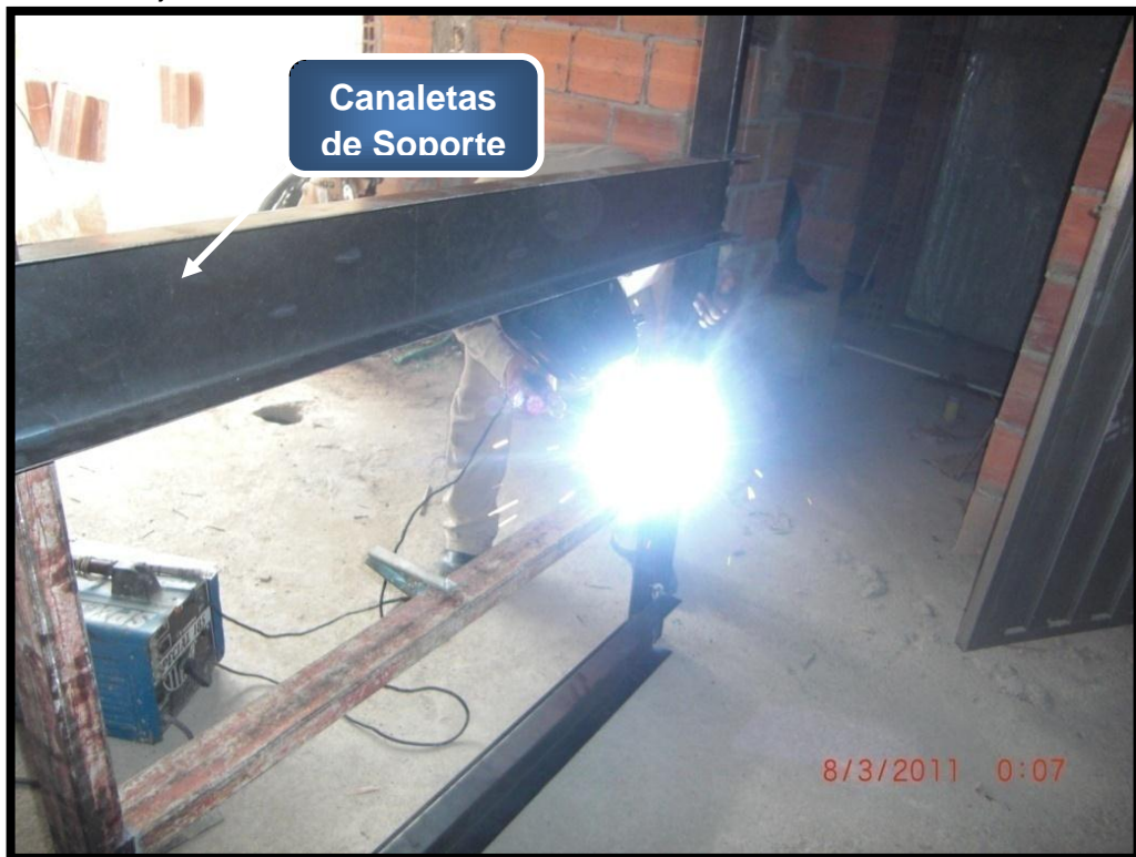
Figura 63. Montaje de Canaletas
