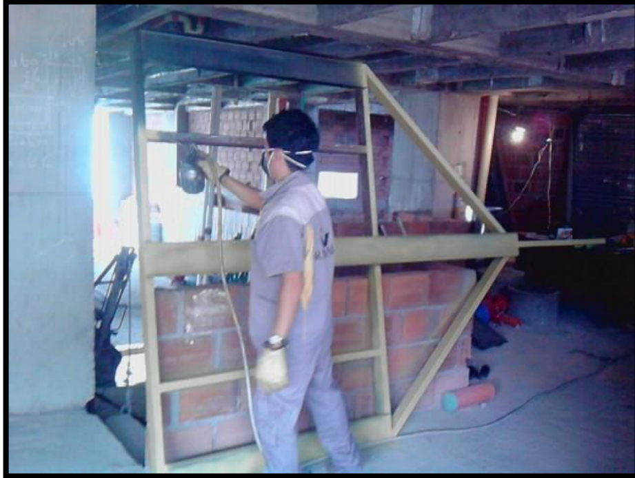
Figura 64. Recubrimiento con pintura anticorrosiva.
