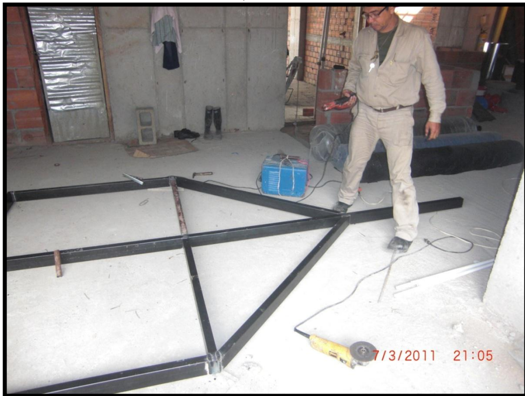
Figura 62. Proceso de Soldadura del Remolque.
