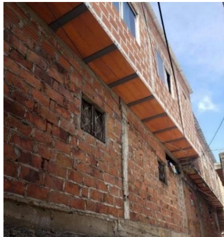
Figura 3. Placa fácil con perfiles metálicos y bloquelón.
