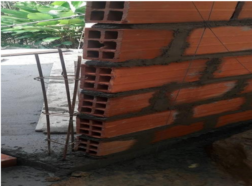
Fotografía 7. Mejoramiento de vivienda rural vereda La Tigra.
