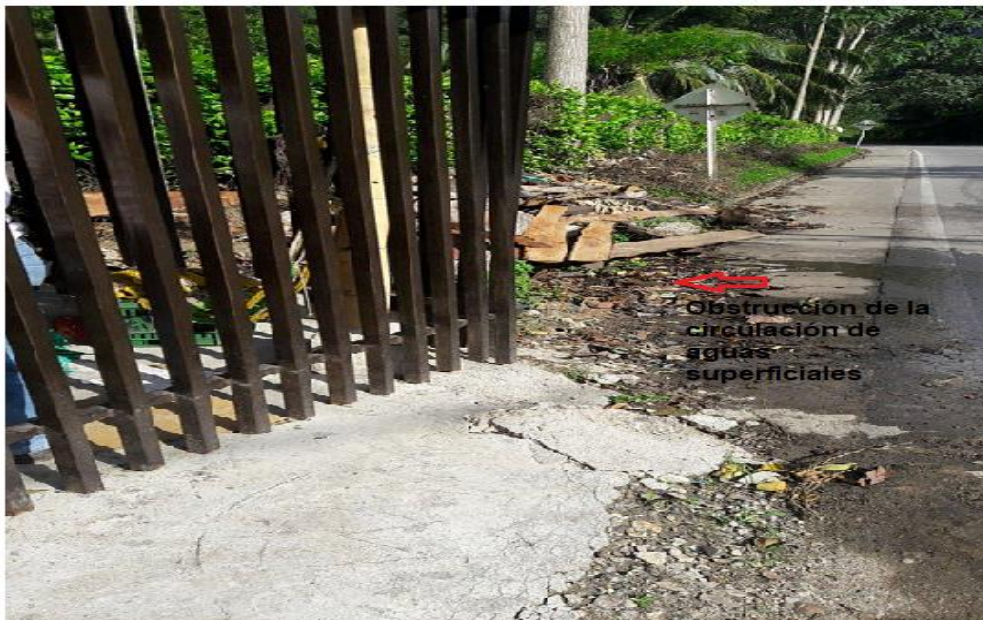
Fotografía 4. Obstrucción del flujo de las aguas superficiales e invasión del área de protección natural.
