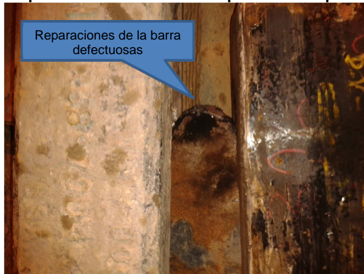
Ilustración 52. Reparaciones hechas en campo barra de apertura
