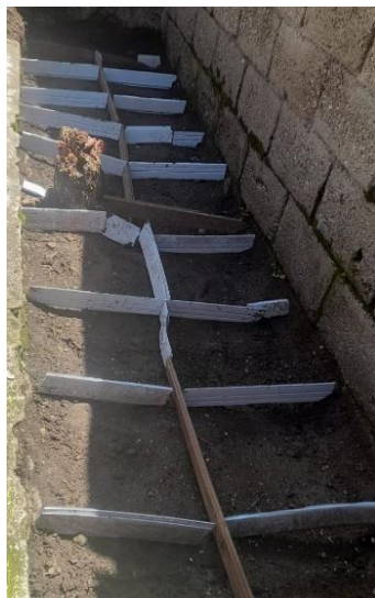
Preparación de terreno
