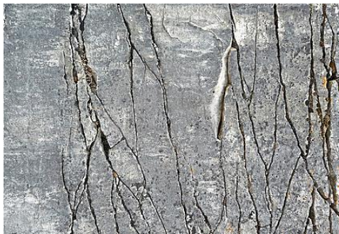
Figura 23. Roca naturalmente fracturada.
