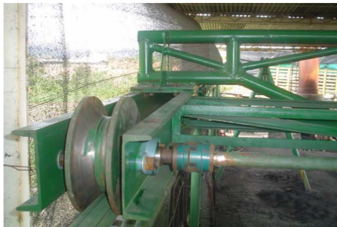
Figura 71. Montaje de las ruedas del puente.
