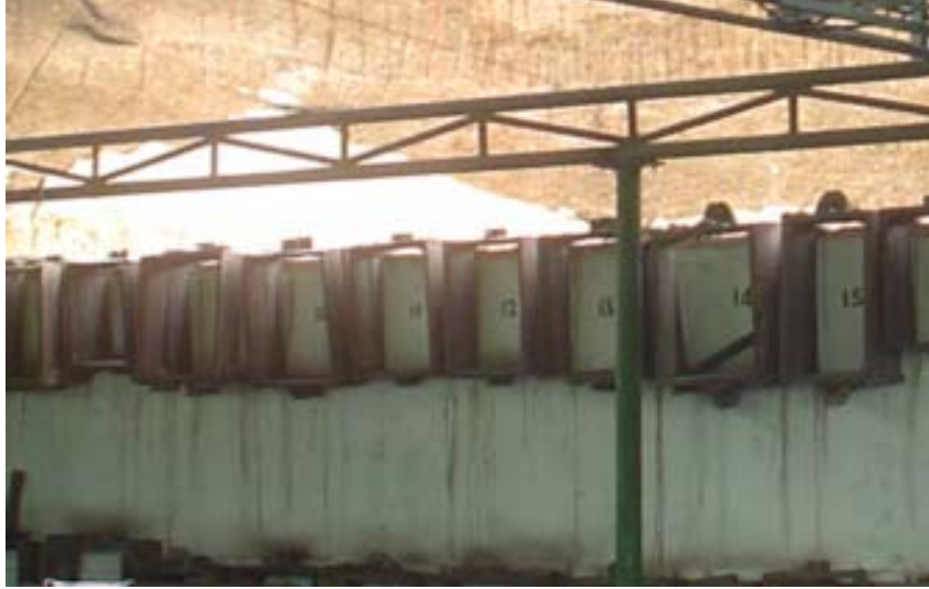
Figura 65. Construcción del Riel.
