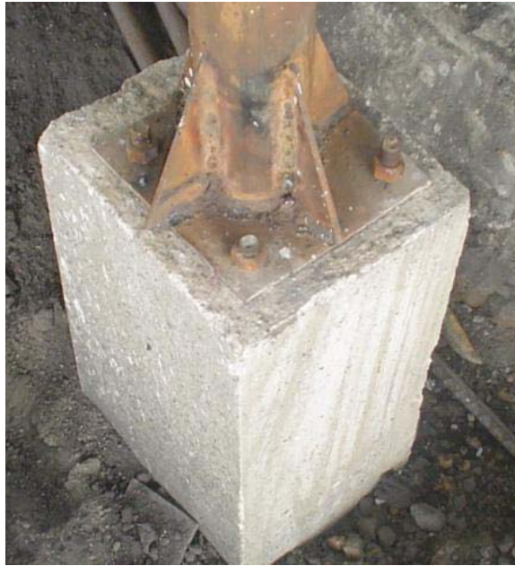
Figura 63. Montaje de la columna a la cimentación.
