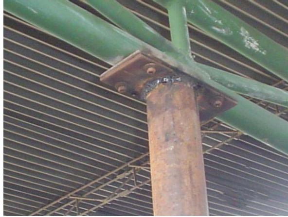
Figura 64. Montaje de la columna al riel.
