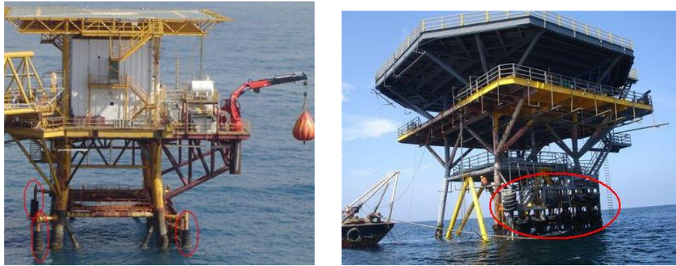
Figura 5.14. Protección contra colisiones de buques
