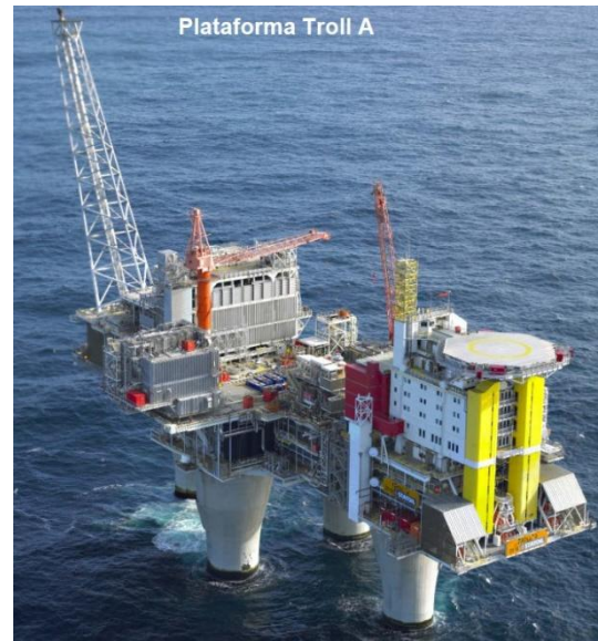
Figura 1.4. Plataforma concrete gravity
