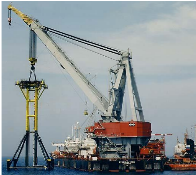
Figura 2.13. Desembarque e instalación de la plataforma
