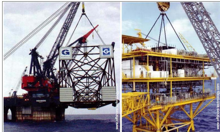
Figura 2.4. Cargue de la plataforma jacket
