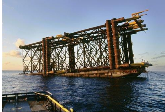
Figura 2.6. Jacket con tanques para flotar
