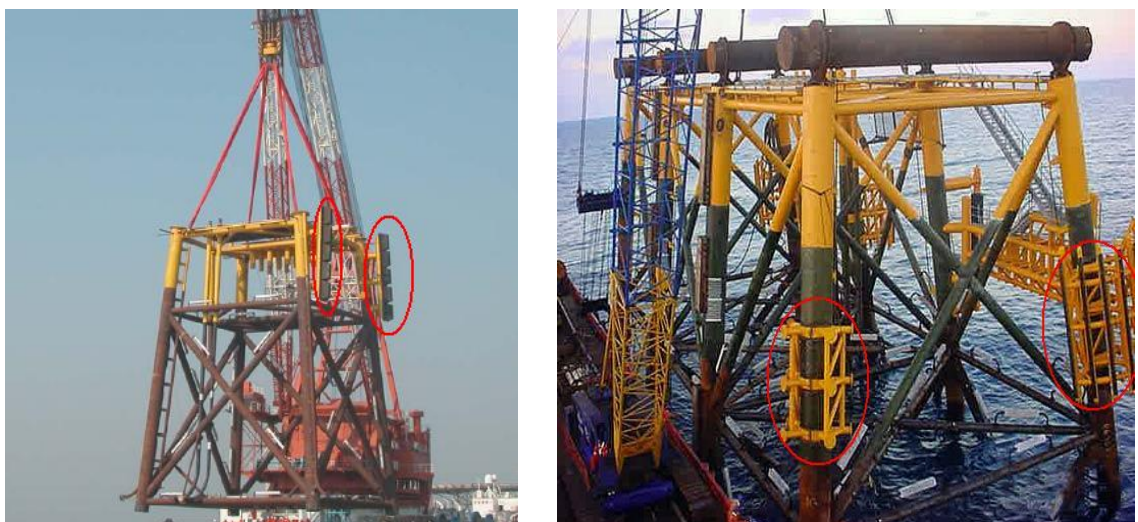
Figura 5.13. Protección contra colisiones de buques
