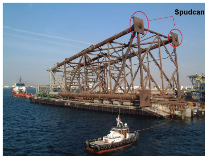
Figura 2.15. Jacket con Spudcan
