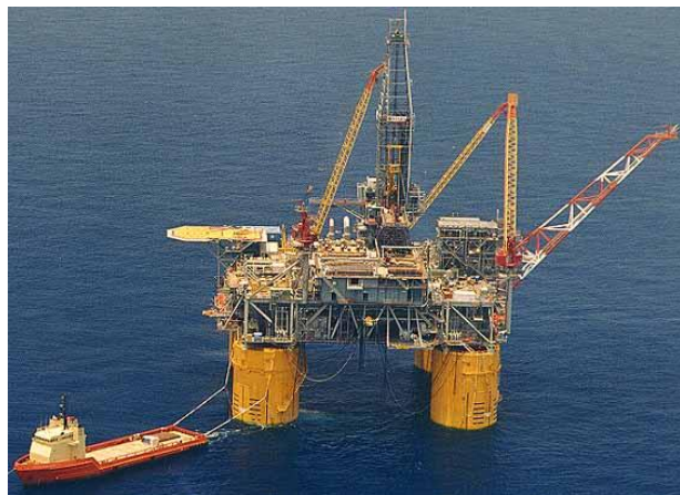
Figura 1.7. Plataforma TLP
