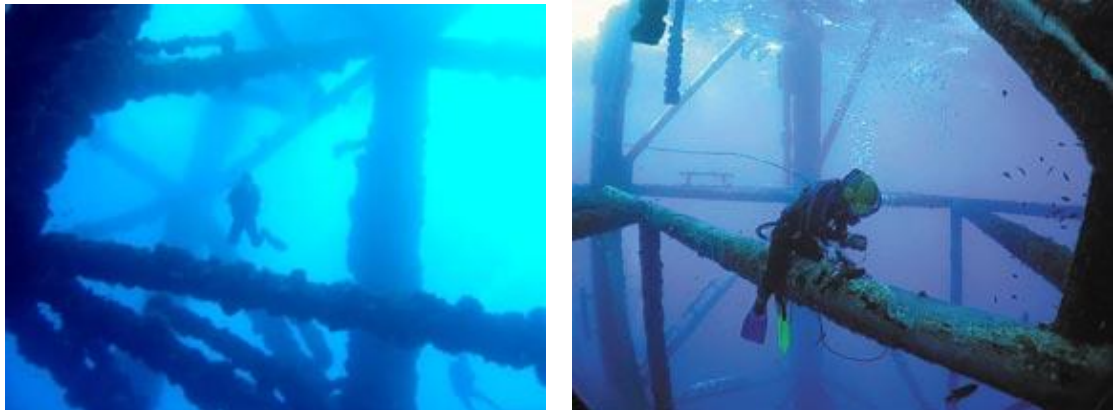
Figura 5.2. Crecimiento marino en plataforma
