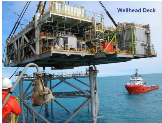
Figura 2.16. Instalación de la cubierta
