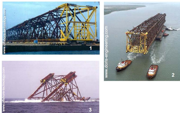
Figura 2.3. Fases de Instalación de la plataforma jacket
