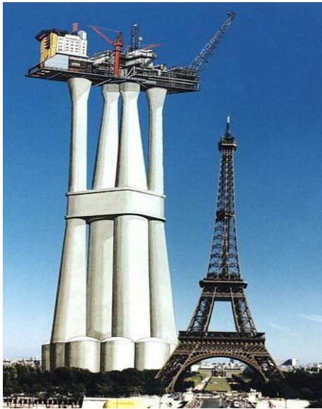
Figura 1.4. Plataforma concrete gravity
