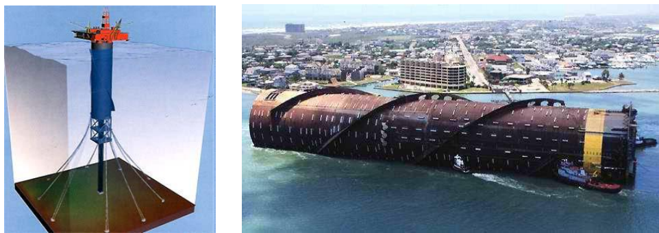
Figura 1.6. Plataforma spar
