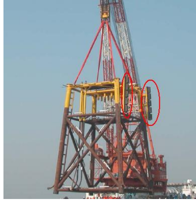
Figura 6.6. Tipo de defensa contra la colisión de buques
