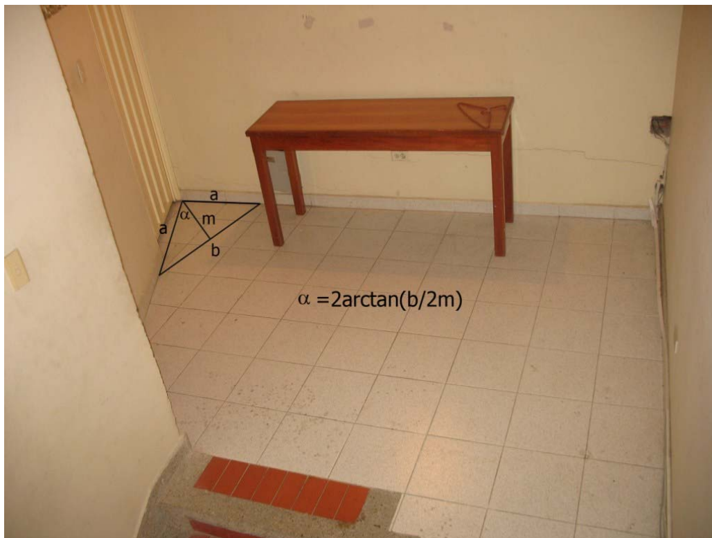
FIGURA 19. Muro oblicuo (Auditorio Fundadores)
