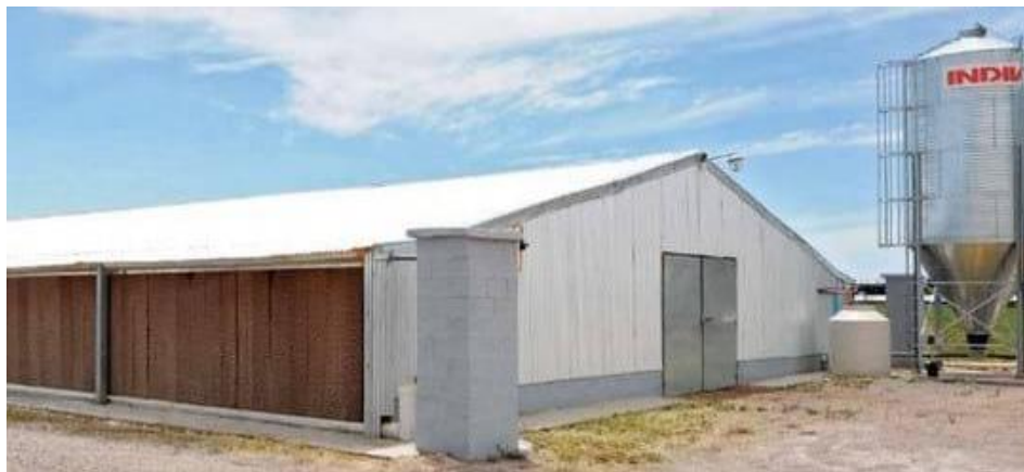
Estructura externa de un galpón avícola
