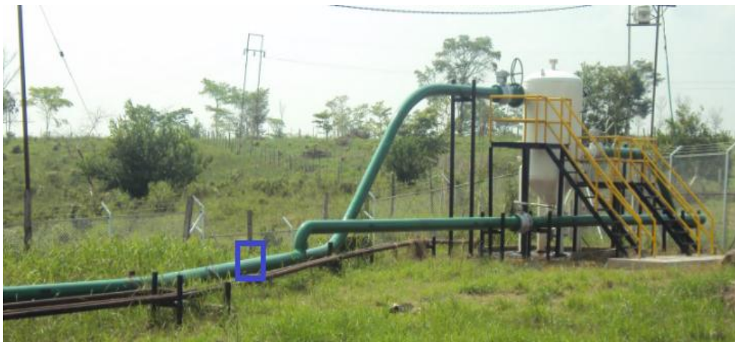
Foto 6. Ubicación portacupón a la salida del tanque de desarenado. Fuente: Los autores.
