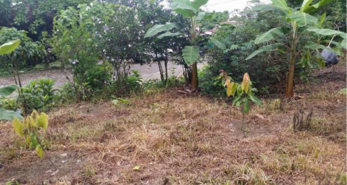
Fotografía 31. Ubicación del oleoducto respecto a la casa con grietas.
