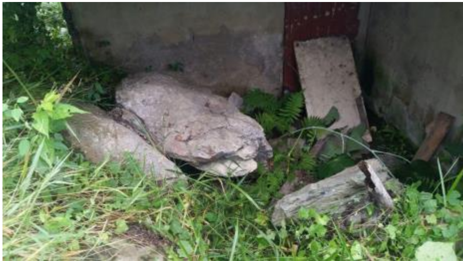
Fotografía 40. Rocas que ocasionaron la destrucción vivienda.
