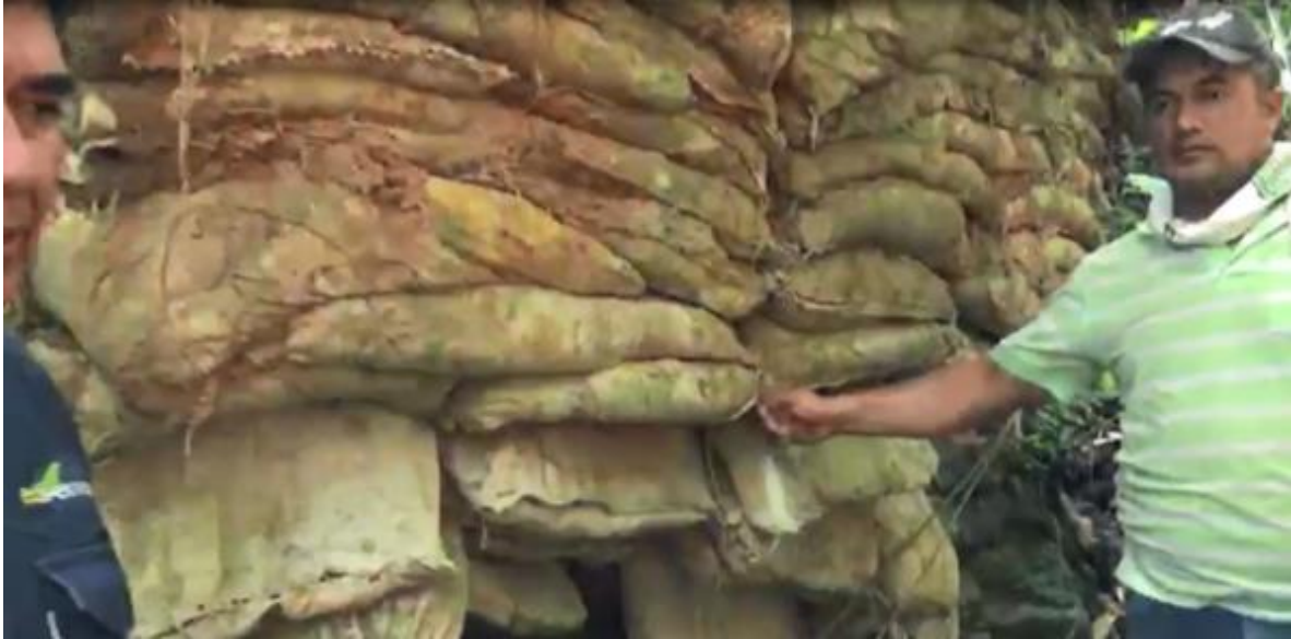
Fotografía 36. Muro de sacos de polipropileno
