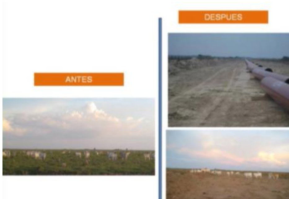
Fotografía 5. Antes y después de oleoducto
