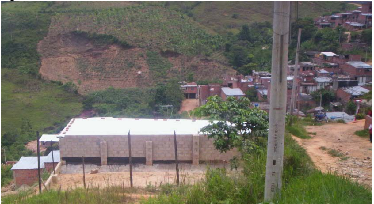
Figura 53. PANORAMICA 2 CONSTRUCCIONES DESDE LA CUMBRE
