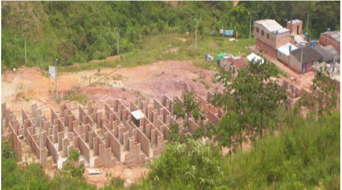
Figura 52. PANORAMICA1 CONSTRUCCIONES DESDE LA CUMBRE
