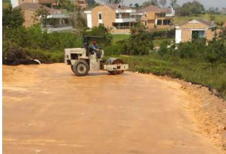
Figura 10. Compactación del material después de la recuperación.
