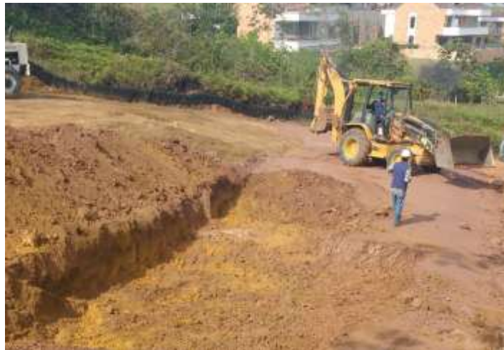
Figura 7. Remoción de capas de relleno.
