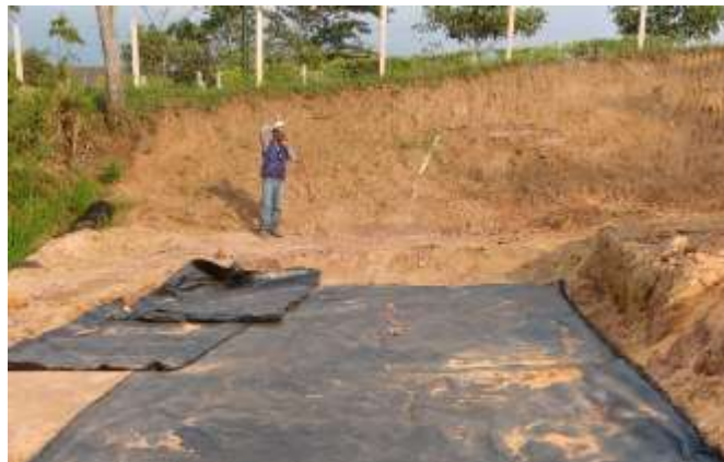
Figura 8. Geotextil T-1700 extendido y anclado con pines casa 2 mts en ambos sentidos.
