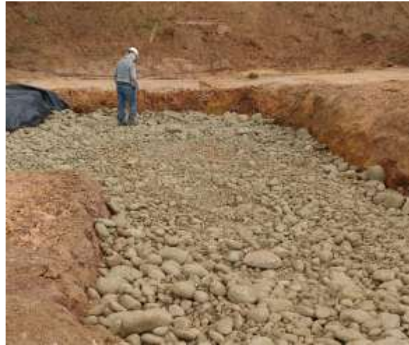
Figura 9. Colocación de crudo de río.
