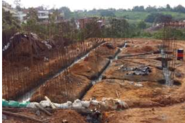
Figura 14. Armado de muro de contención y arranque de columnas.
