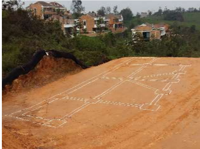
Figura 11. Compactación del material después de la recuperación.
