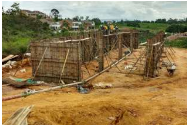
Figura 17. Fundida de elementos con bomba estacionaria.
