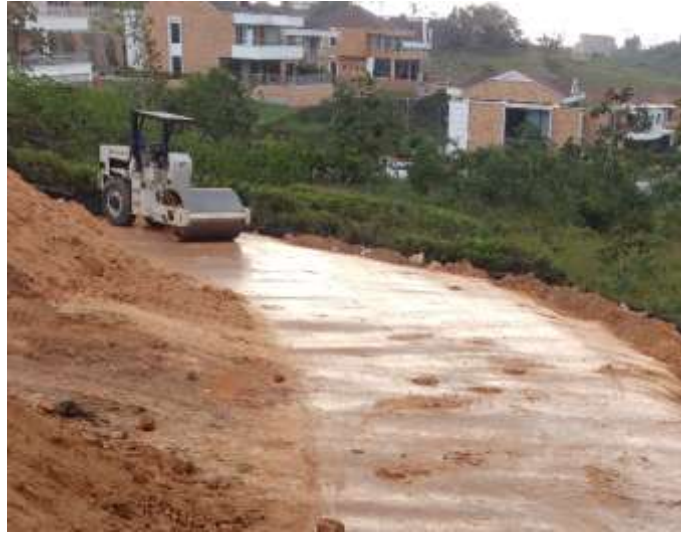
Figura 4. Compactación de primeras capas con vibro compactador de rodillo.
