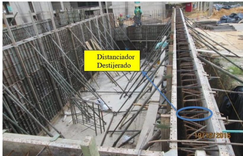
Figura 7. Corbatas destijeras para mantener el espesor de los muros del tanque.
