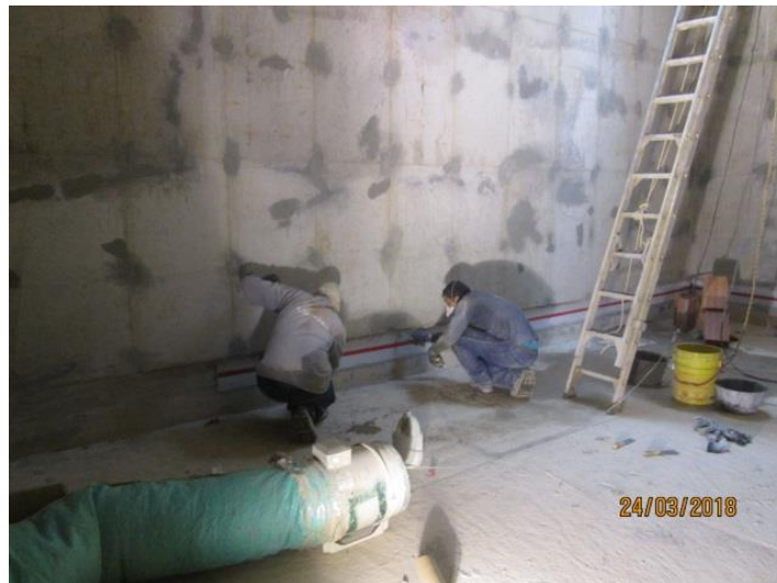
Figura 11. Instalación de la cinta Sikadur Combiflex SG.
