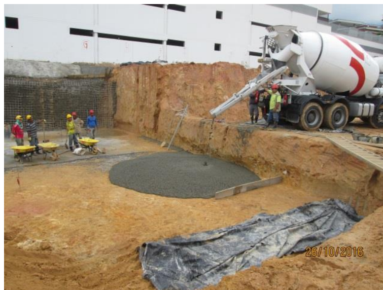
Figura 4. Protección del fondo del tanque con Concreto de limpieza de 1500 psi.
