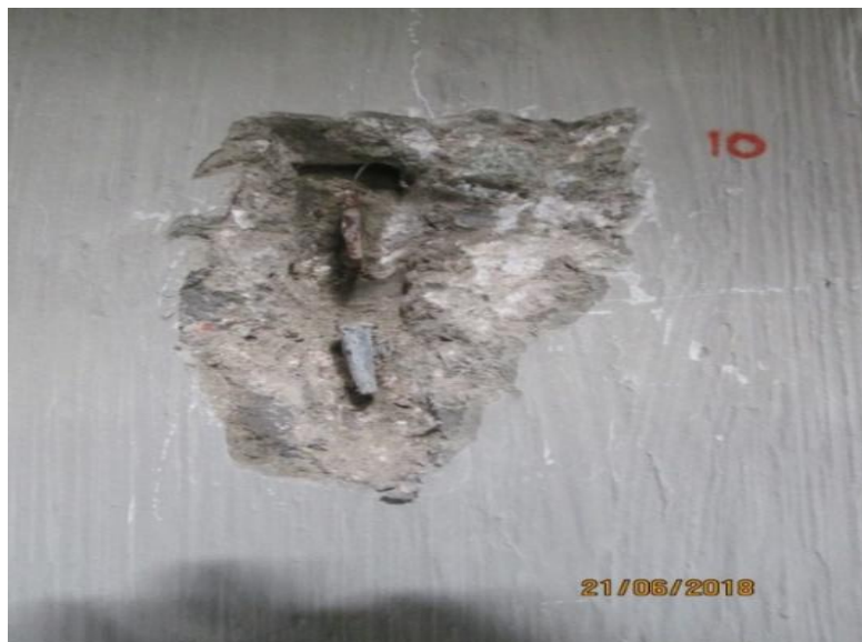
Figura 12. Resane corbatas tanque de almacenamiento agua potable.
