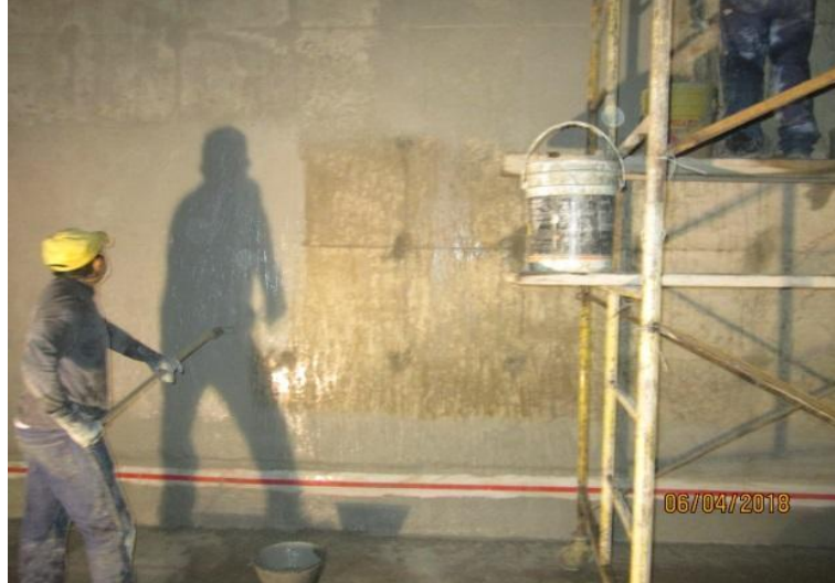
Figura 13. Impermeabilización del tanque de almacenamiento de agua potable.
