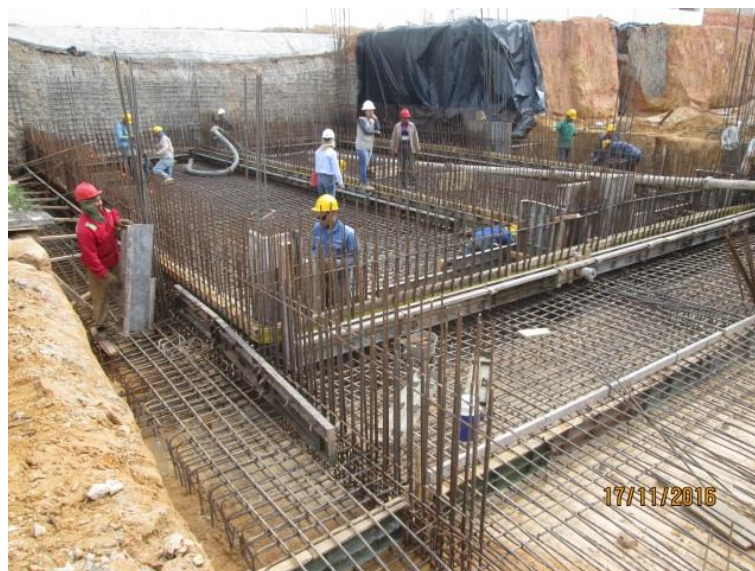
Figura 5. Instalación de acero de refuerzo en la placa de cimentación.
