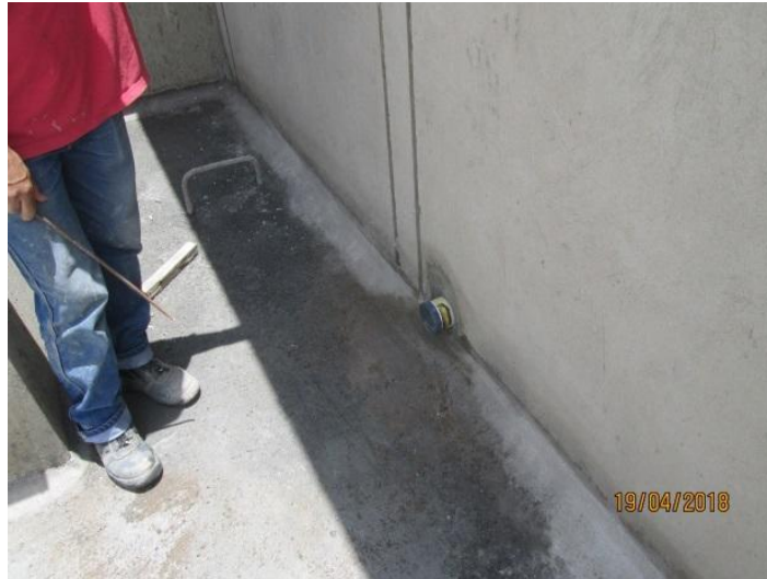
Figura 17. Prueba de estanqueidad en tubería de PVC para bajante de aguas lluvias
