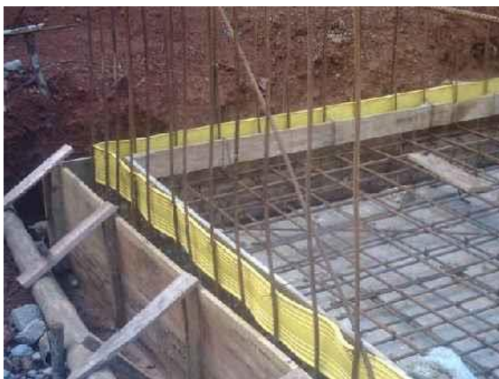
Figura 6. Forma de instalación de la cinta PVC.(Fondo Financiero de Proyectos de Desarrollo (FONADE), 2007). Recuperado de https://www.fonade.gov.co/geotec/SuperPRO/InformeFotograficoA.ashx?Proyecto=2052565&Convenio=194048 .
