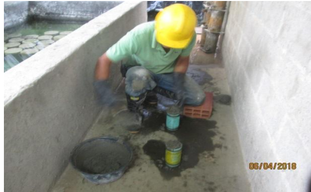
Figura 18. Toma de cilindros de mortero
