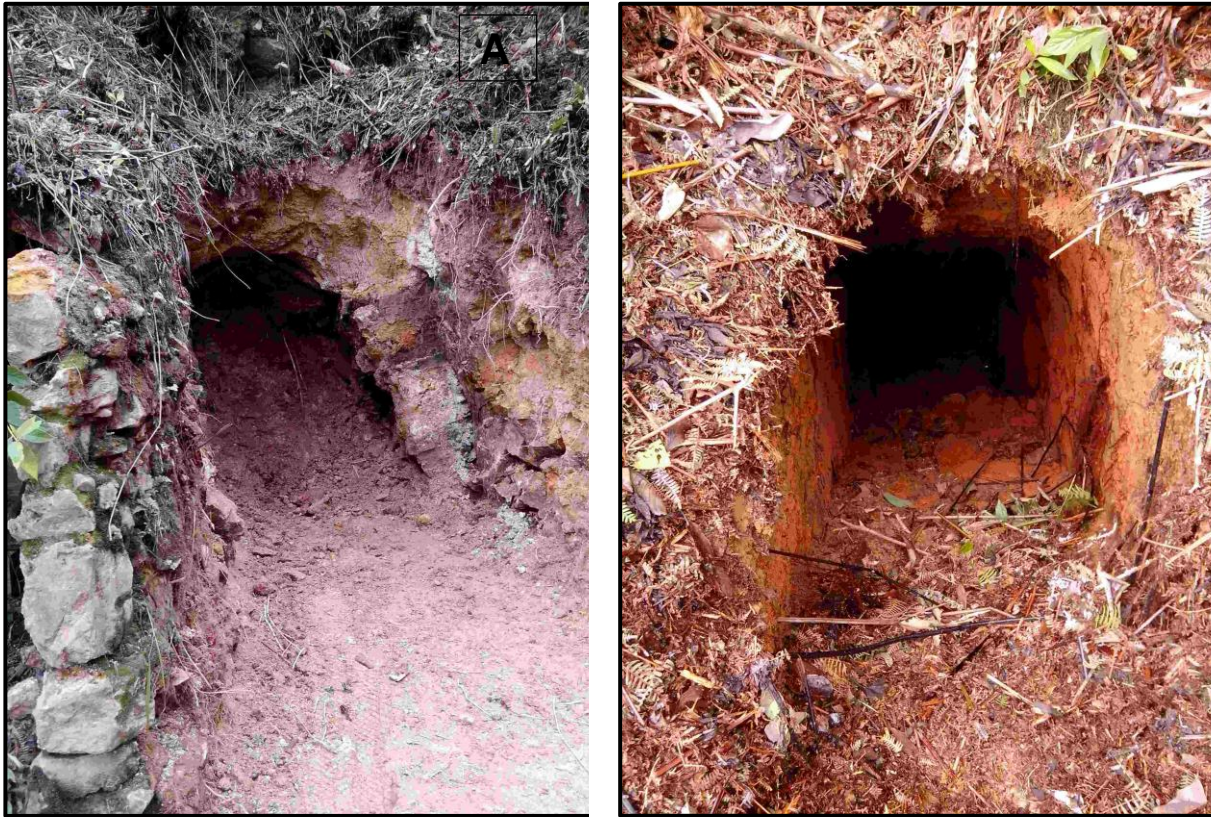
Figura 37 A y 37B. Trabajos antiguos colapsados, con riegos de cuarzo.
